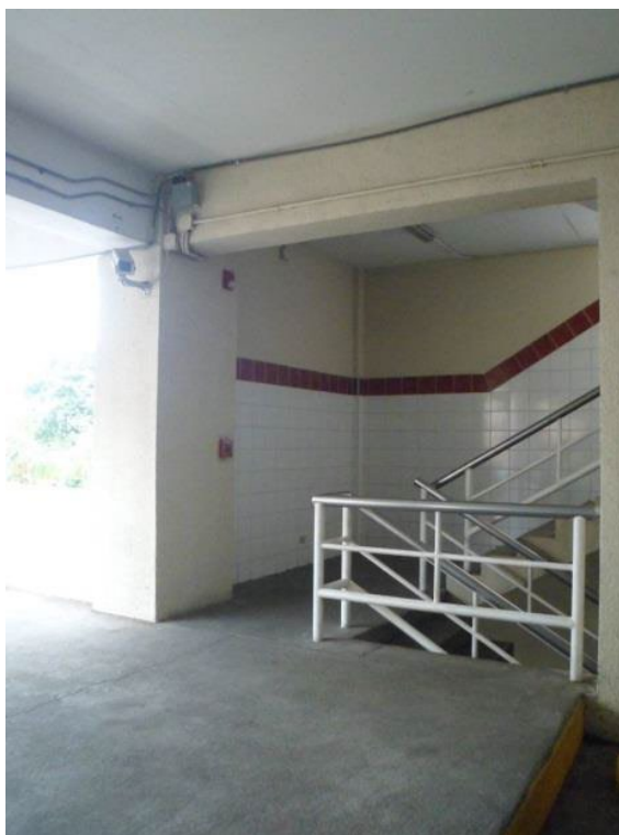
Figura 11: Escalera de circulación
