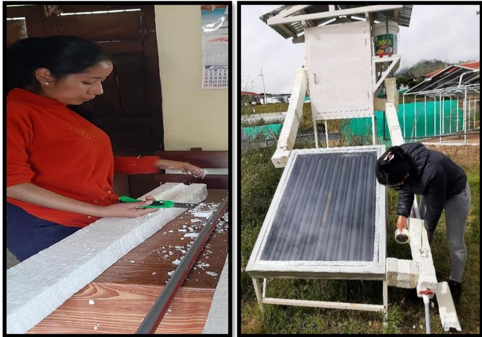
**Figura 17.** Aislamiento térmico del sistema de tuberías.
