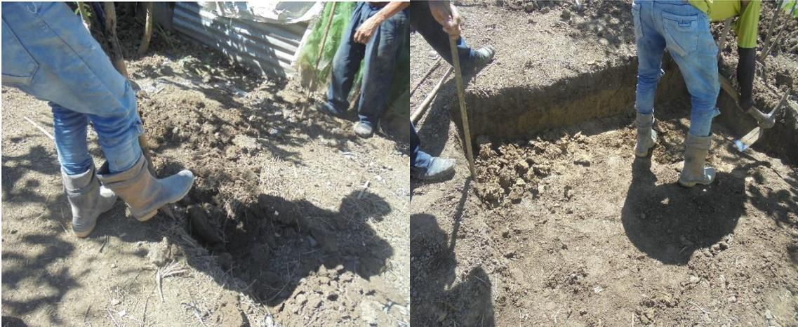
**Figura 52:** *EXCAVACIÓN PARA CIMIENTOS.*
