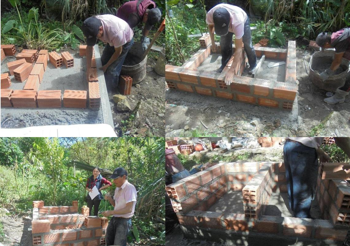
**Figura 41:** PEGADO DEL LADRILLO PARA LAS CÁMARAS DE SECADO.
