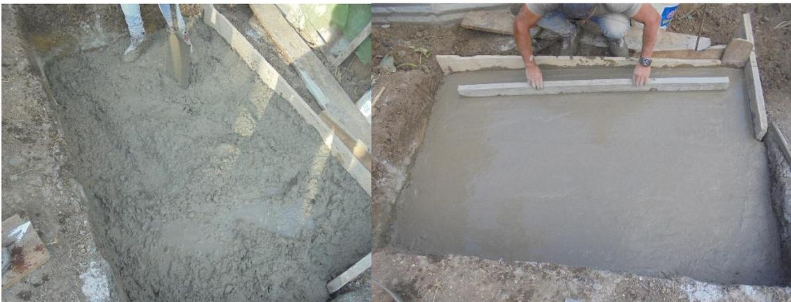
**Figura 53:** *ENCOFRADO Y VACIADO DE CONCRETO CICLÓPEO*
