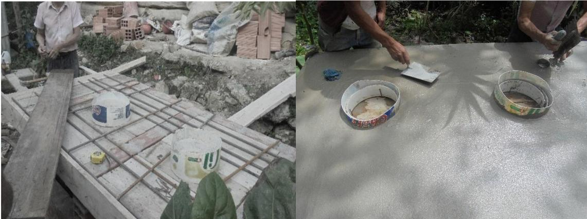
**Figura 42:** ENCOFRADO Y VACIADO DE CONCRETO EN CÁMARAS DE SECADO.
