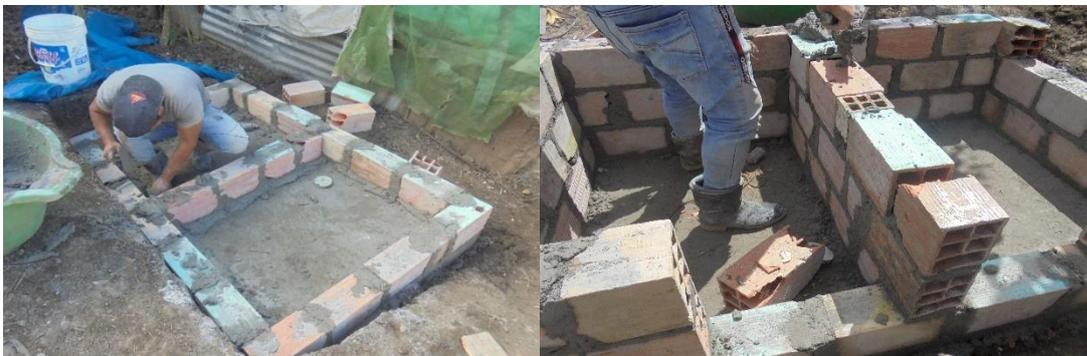
**Figura 54:** *PEGADO DE LADRILLO EN CÁMARAS COMPOSTERAS*
