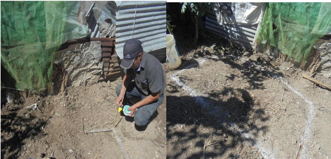
**Figura 51:** *TRAZO Y REPLANTEO DEL BES.*
