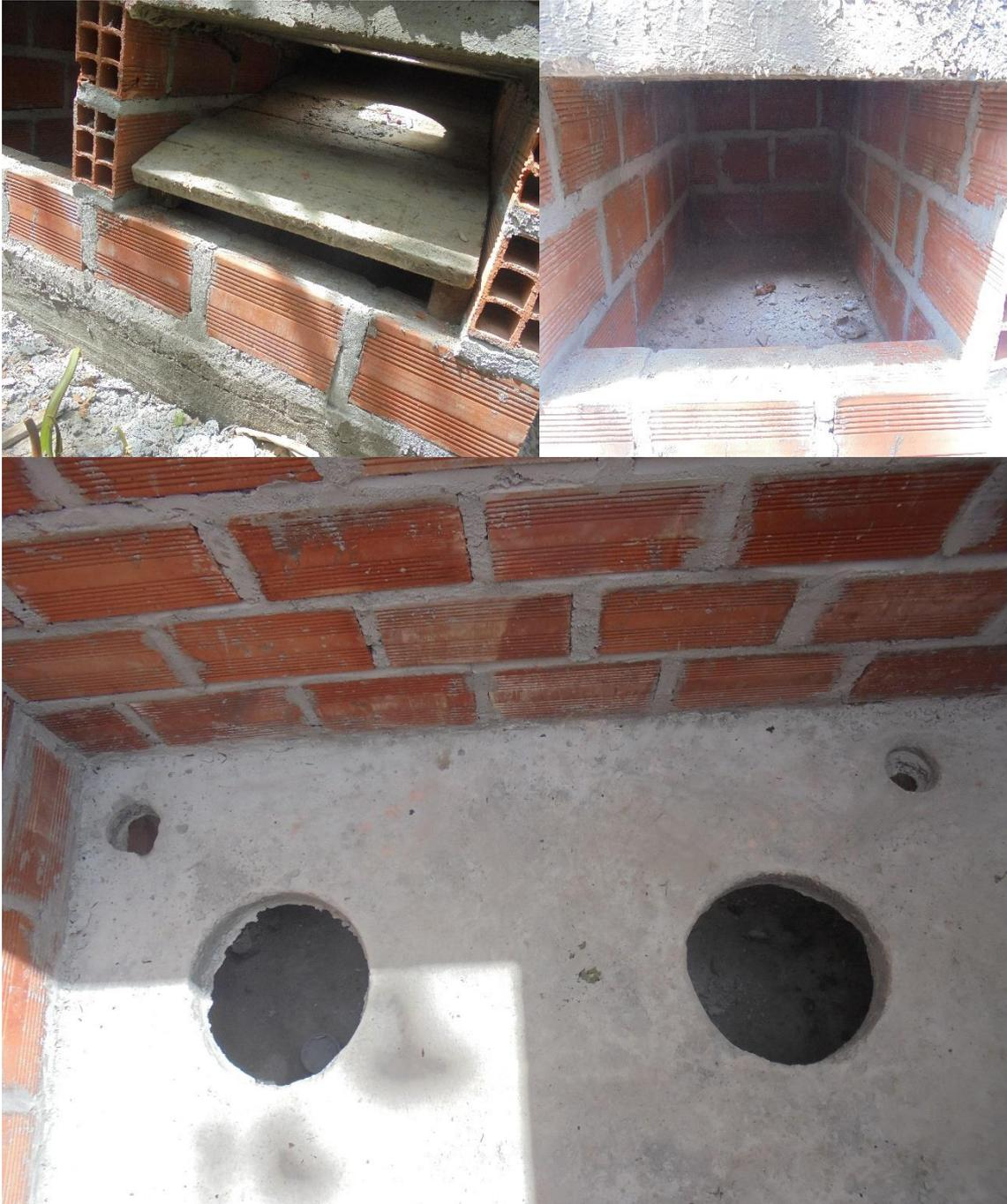
**Figura 44:** *DESENCOFRADO DE LAS CÁMARAS COMPOSTERAS.*
