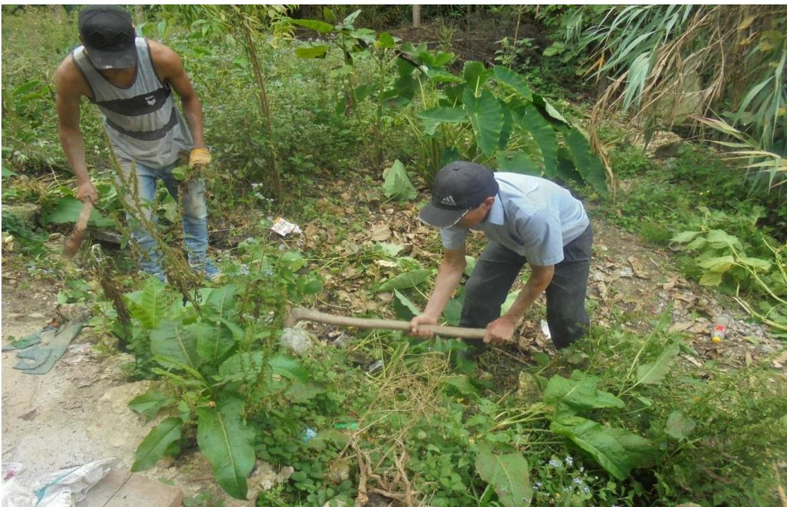
**Figura 38:** LIMPIEZA DEL TERRENO CON HERRAMIENTAS MANUALES.
