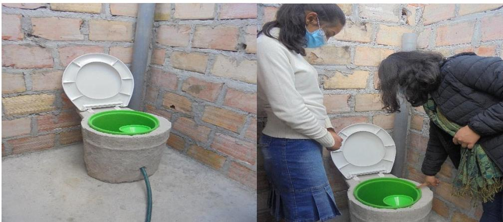
**Figura 57:** WÁTER SEPARADOR INSTALADO
