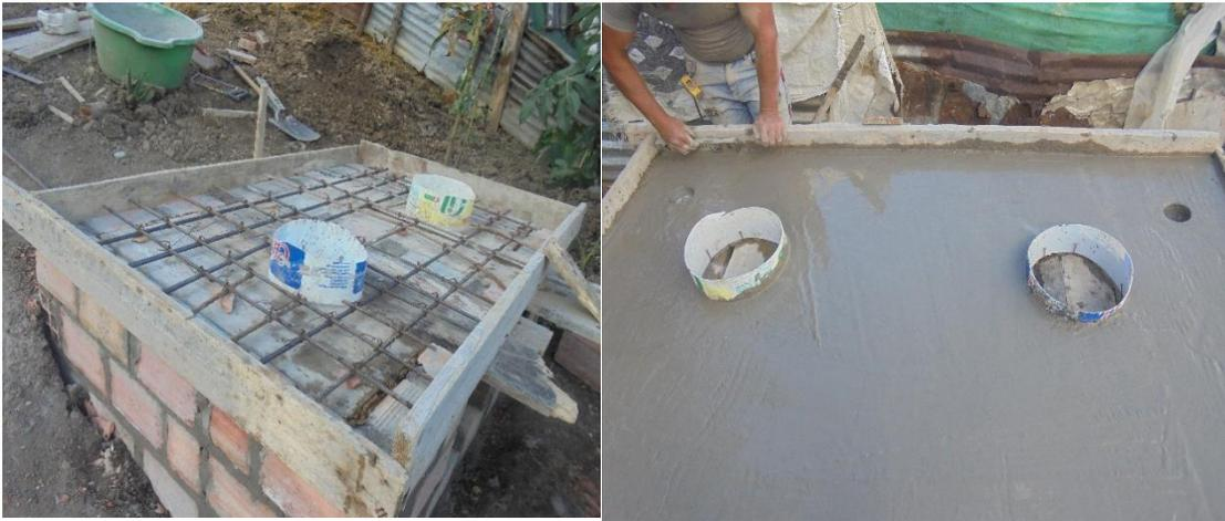
**Figura 55:** VACIADO DEL CONCRETO EN TECHO DE CÁMARAS COMPOSTERAS.
