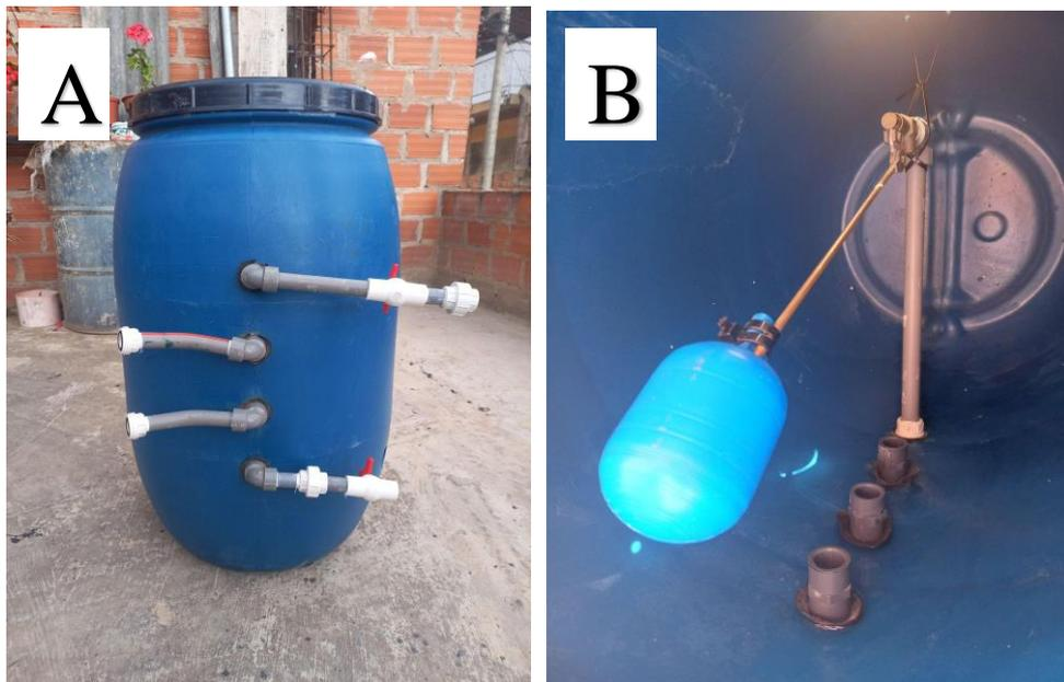
**Figura 12.** (A) Instalación de accesorios, (B) Instalación de válvula de llenado automático.
