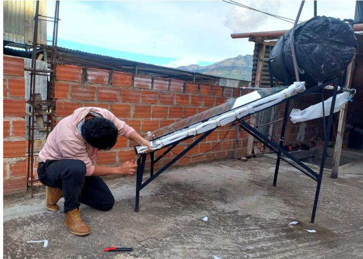
**Figura 14.** Forrado de tuberías externas.
