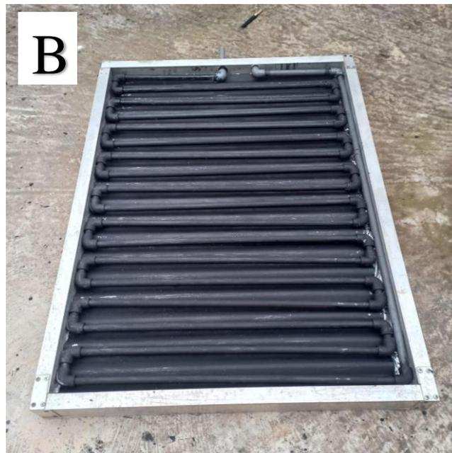
**Figura 5.** (A) Pintado de calaminas, (B) Colocación de calamina y fijación de parrilla
