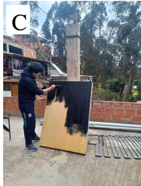
**Figura 6.** (A) Diseño de caja de colector, (B) Fijación de triplay, (C) Pintado de la base de triplay.
