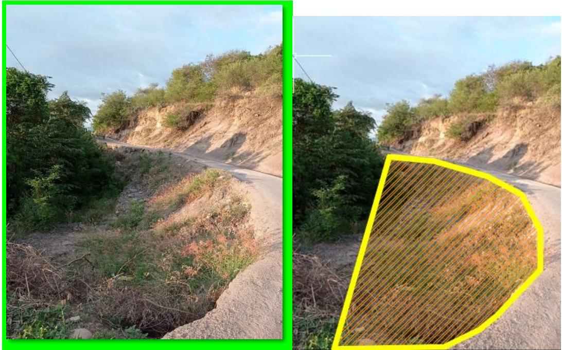
Figura 1. Tramo del km 06+820 al km 06+880
