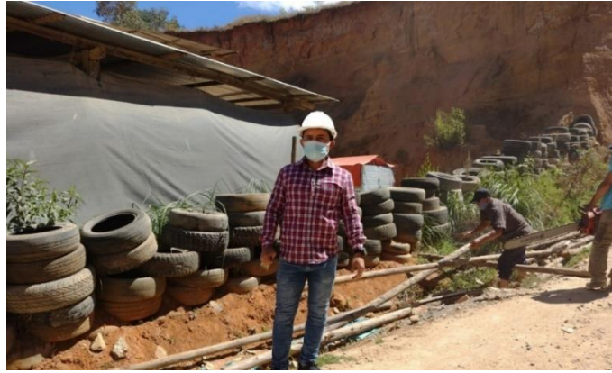
Figura 2. Muro bajo con neumáticos usados empíricamente en la ciudad de Chachapoyas.
