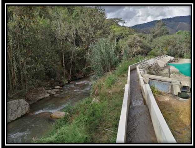
Figura 29. Canal principal de la piscigranja
