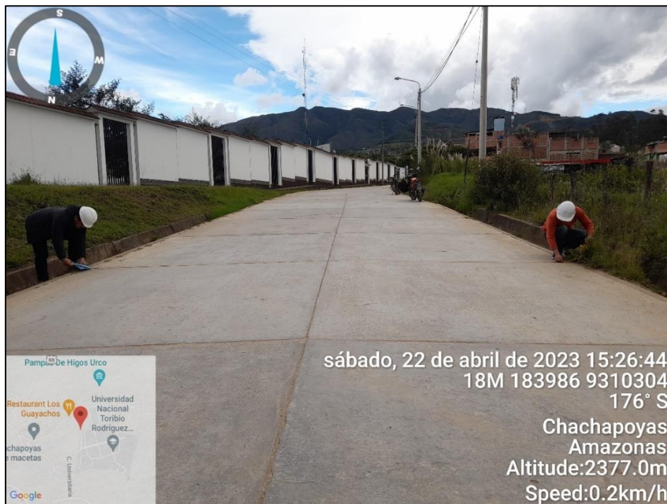
Inspección visual in situ – Calle Universitaria cuadra 4
