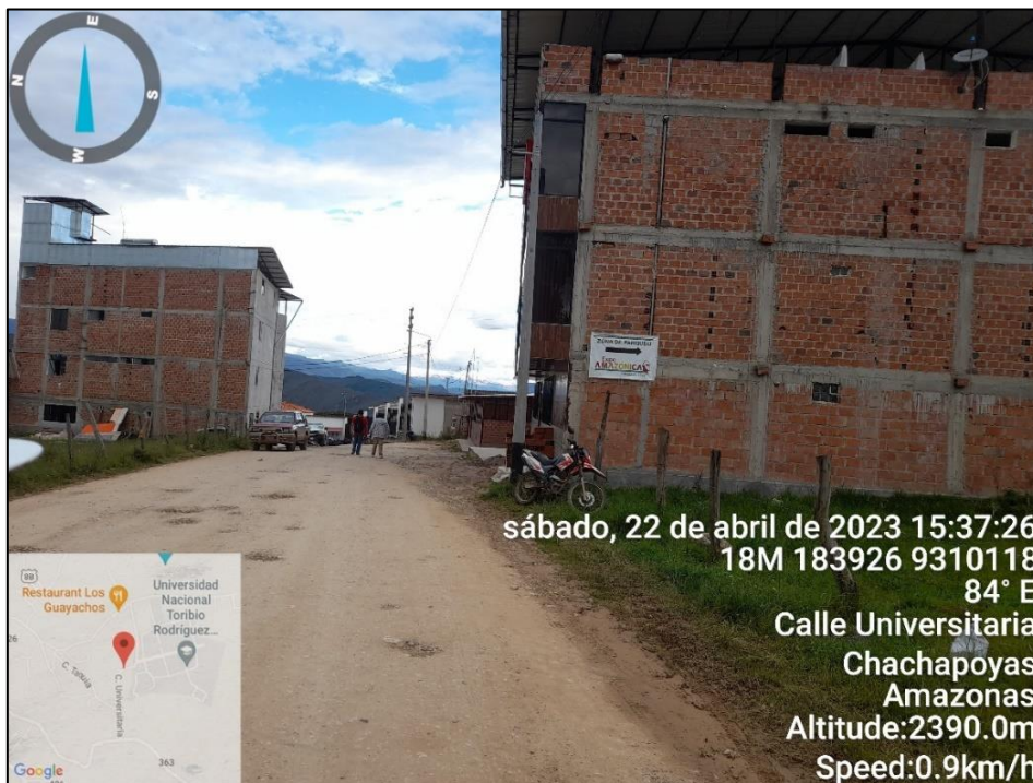
Inspección visual in situ – Calle Universitaria cuadra 3
