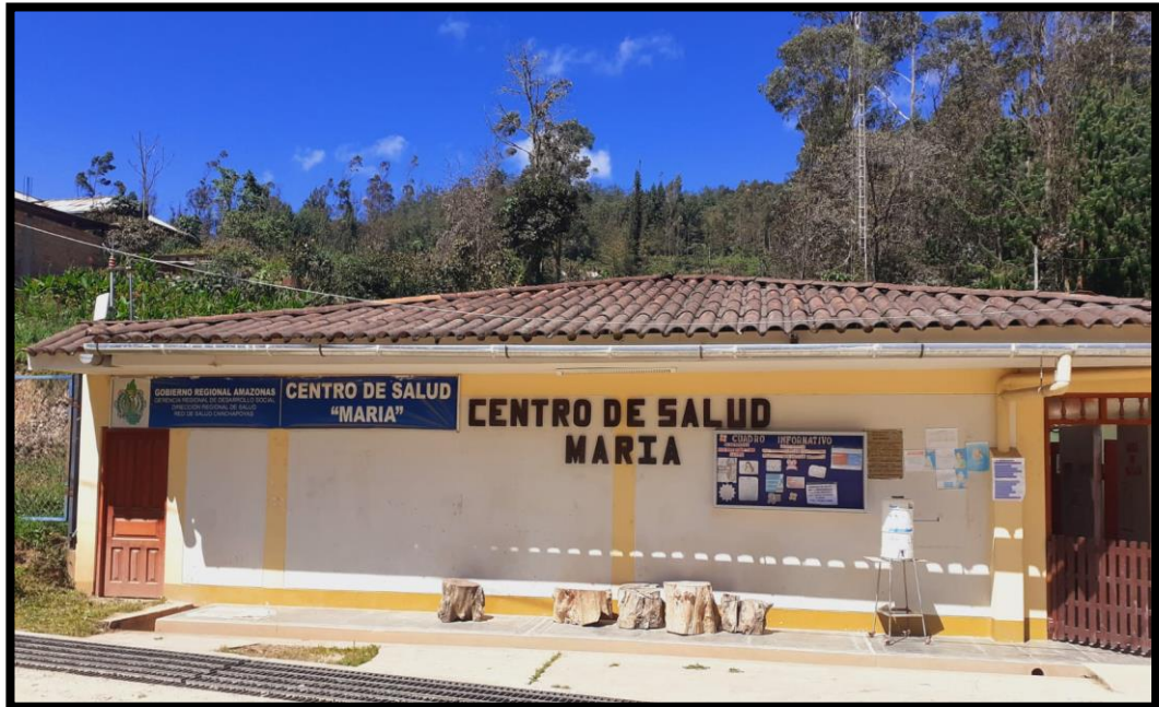
Figura 3: Fachada del Centro Salud I-3, distrito María – Luya- Amazonas 2023.
