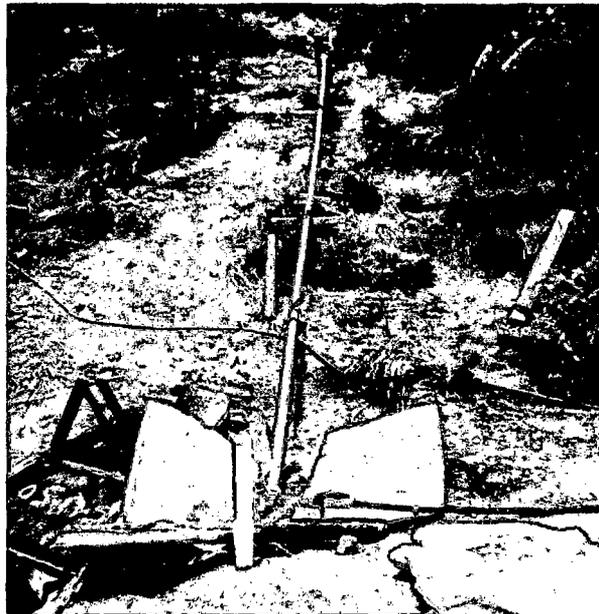
Fotografía 17. Tubería de alimentación de 1" y manguera de descarga de 1/2" de la bomba de ariete hidráulico de 1".
