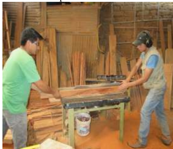
Acondicionamiento de las viguetas en sus dimensiones reales.
