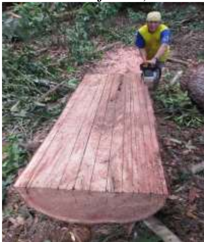
Aserrado de las viguetas ( Cedrelinga Cateniformis ).
