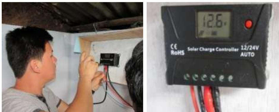
Figura 7. Conexión del panel fotovoltaico al regulador de carga del sistema fotovoltaico.
