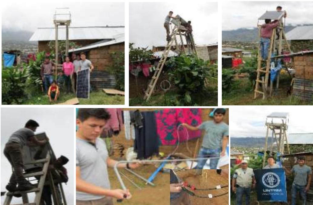
Figura 5. Montaje del panel fotovoltaico.
