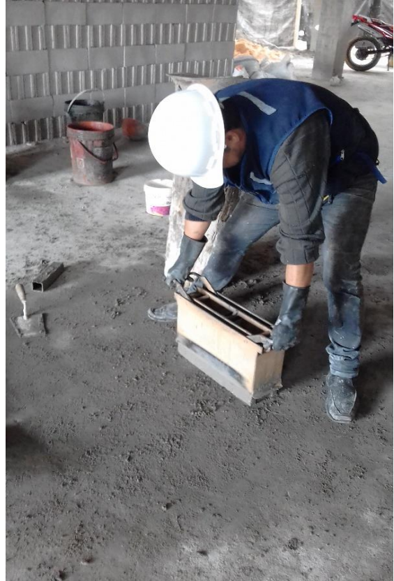
Foto 9: Elaboración de los bloques de concreto y desmolde de los bloques.
