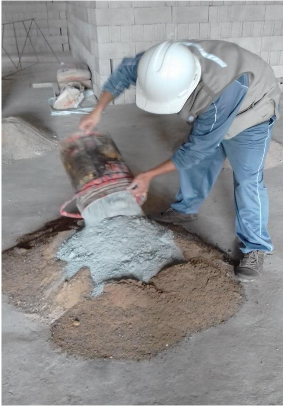
Foto 7: Mezclado de los agregados en seco después de cada dosificación.
