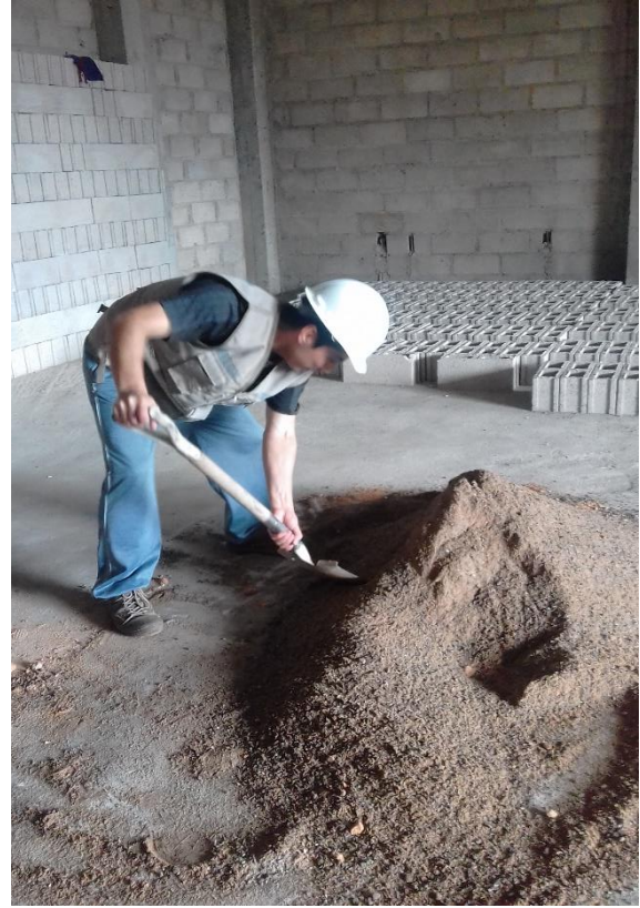
Foto 7: Mezclado de los agregados en seco después de cada dosificación.
