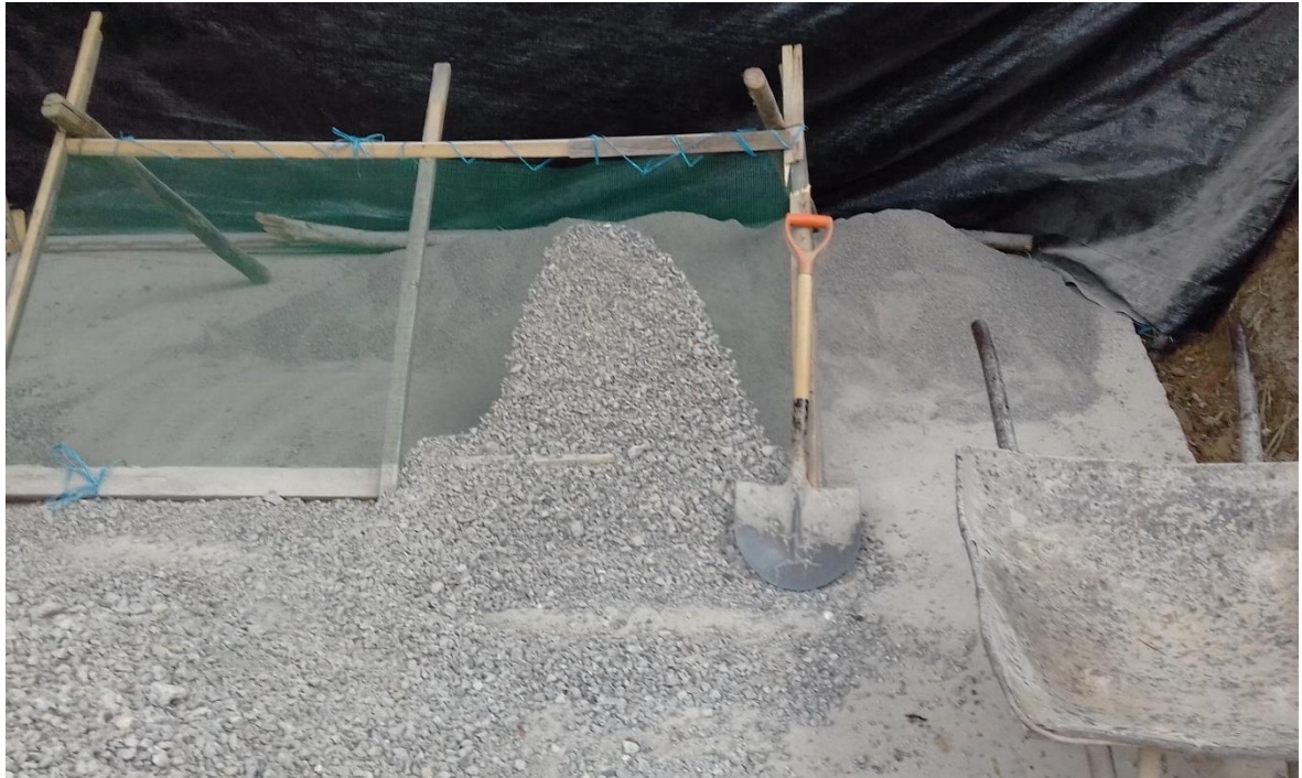
Foto 3: Selección de los escombros triturados de losa de pavimento rígido.
