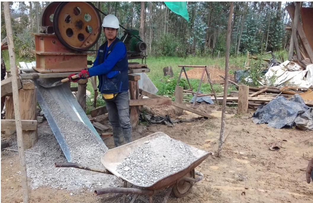
Foto 2: Proceso de triturado de los escombros de losa de pavimento rígido.
