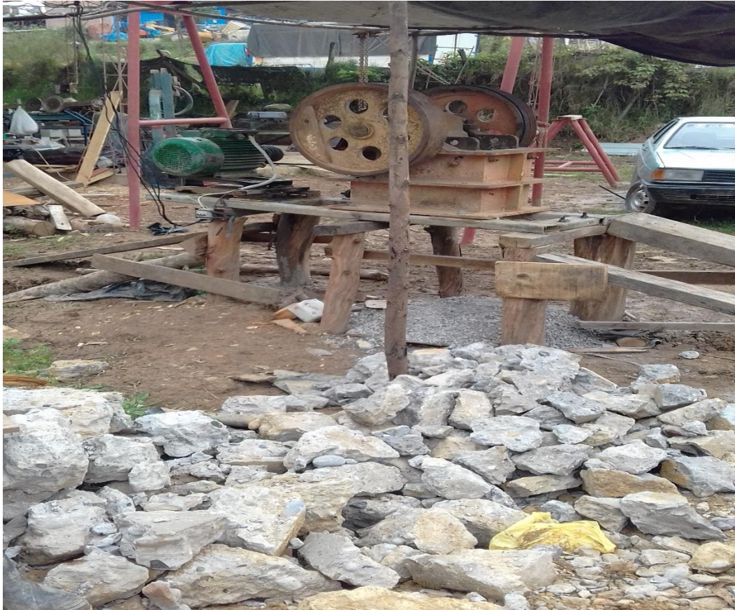
Foto 1: Escombros obtenidos de la demolición de los pavimentos de la plaza de armas de Chachapoyas – Amazonas.
