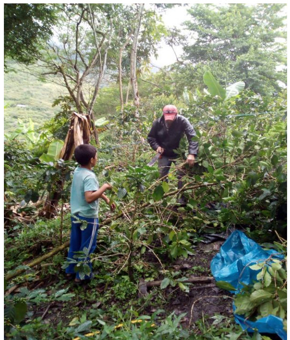
Imagen N° 08: Derribo de las plantas de café con el personal de apoyo
