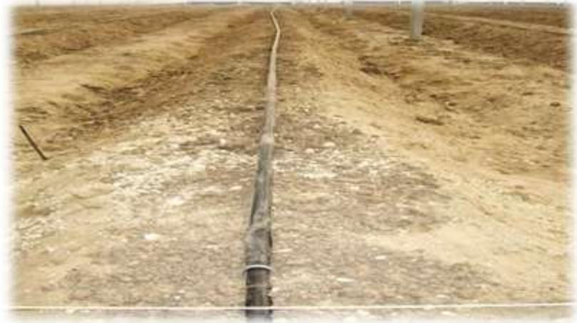
*Figura 31.* Encamado y colocación del sistema de riego
