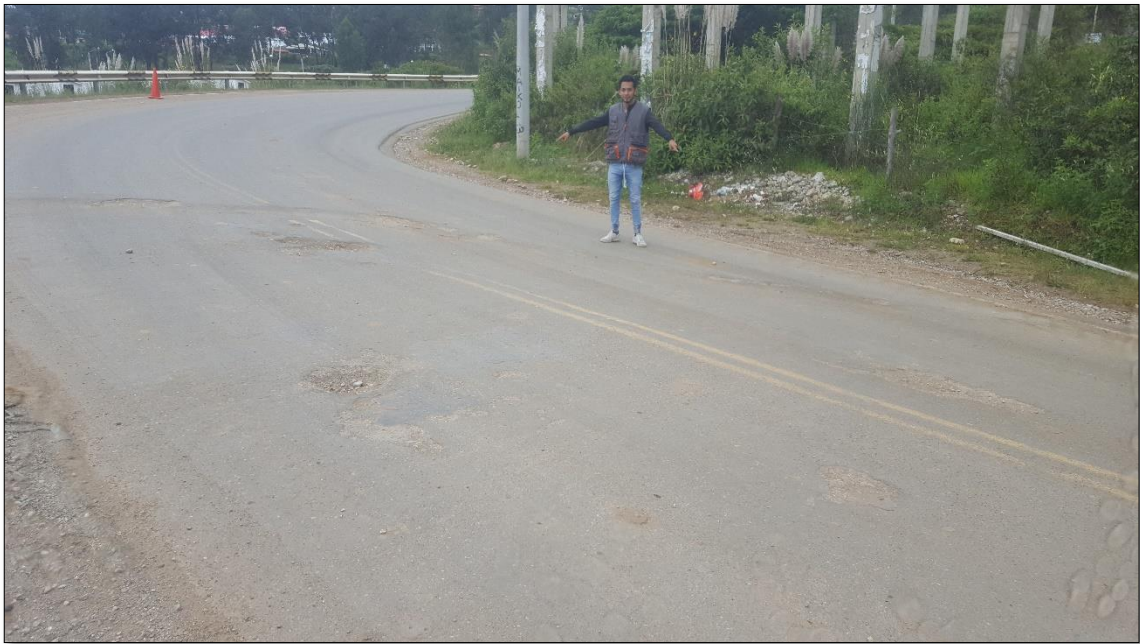
Fotografía 6. Hundimientos (F4) de severidad (A) registrada en UM-04 y UM-05
