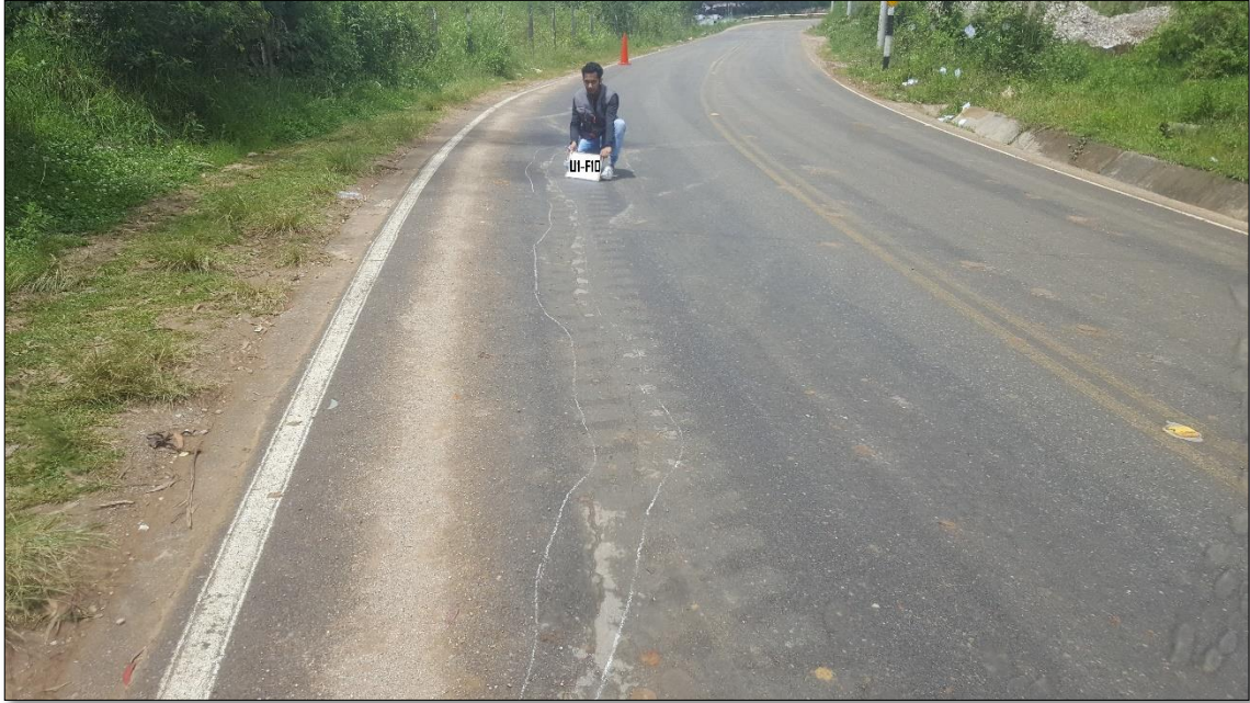
Fotografía 3. Grieta longitudinal (F10) de severidad (M) registrada en UM-01
