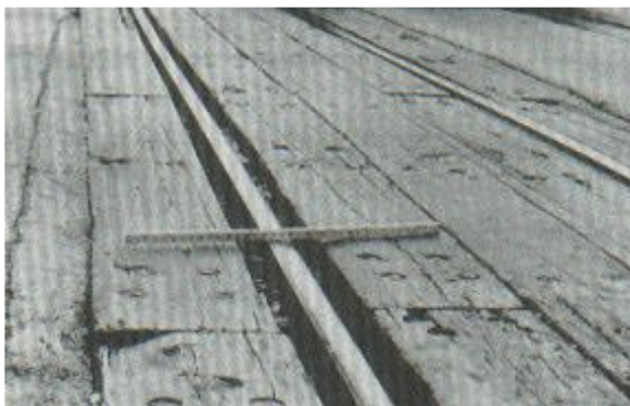
Figura 14. Cruce de vía férrea
