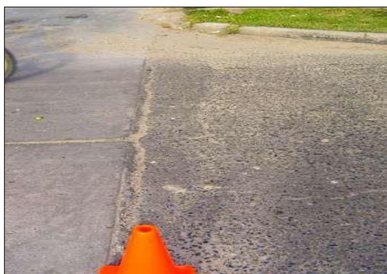
Figura 16. Desplazamiento
