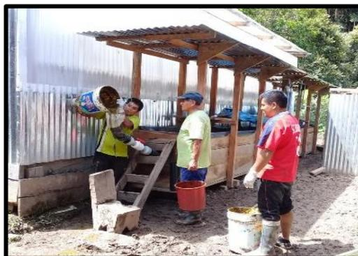
**Figura 13.** Carga de la mezcla al biodigestor
