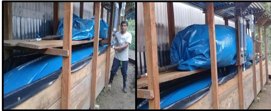
**Figura 14.** Biodigestor con cúpula llena de biogás y trasvase al gasómetro.
