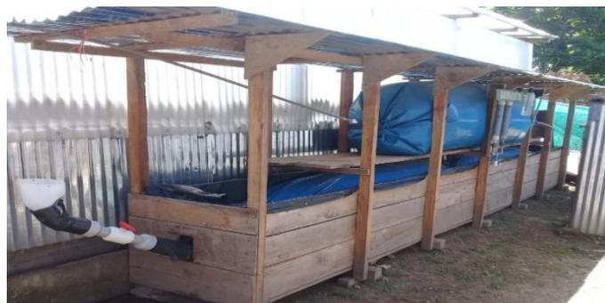
**Figura 15.** Biodigestor lleno de biogás en su cúpula y en el gasómetro.
