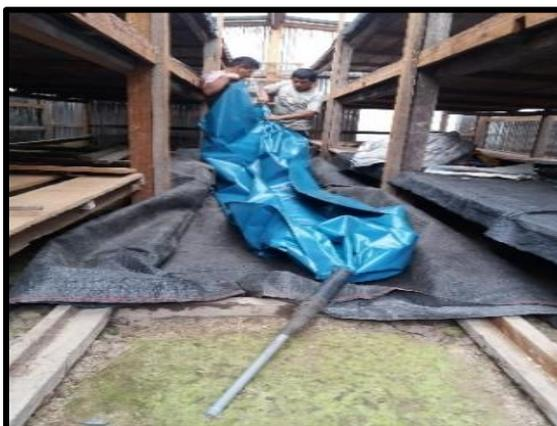
**Figura 9.** Elaboración del gasómetro para biogás.
