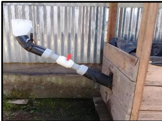
**Figura 7.** Tubo de carga o alimentación del biodigestor.
