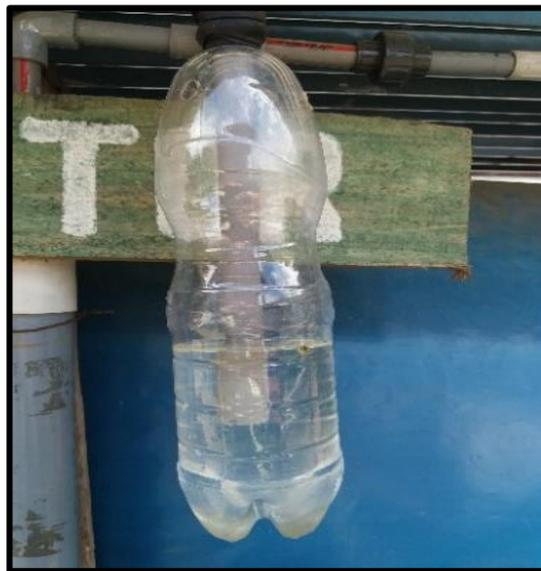
**Figura 11.** Sistema de control de presión de biogás.
