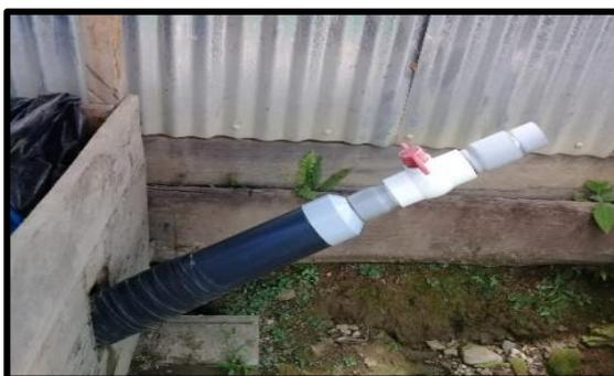
**Figura 8.** Tubo de descarga del biodigestor (Salida de bioabonos).
