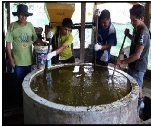
**Figura 12.** Preparación de la mezcla para cargar el biodigestor.
