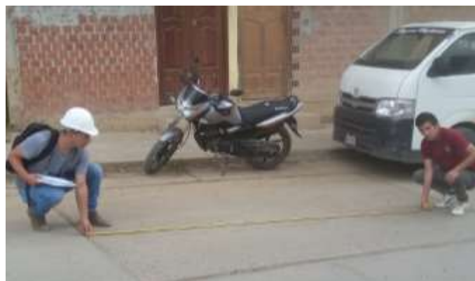
Figura 23. Fisura Longitudinal
