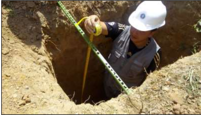
Foto N° 4: Medición de profundidad de calicata
