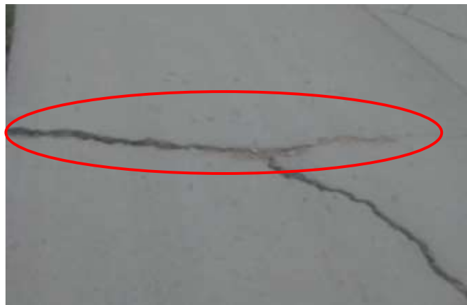
Figura 25. Fisura Transversal
