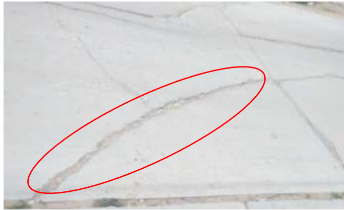
Figura 29. Fisura Oblicua
