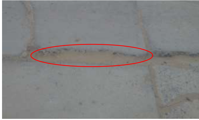
Figura 31. Despostillamiento de junta
