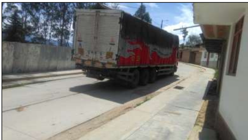
Foto N° 21: Transito de camión pesado en el área dañada
