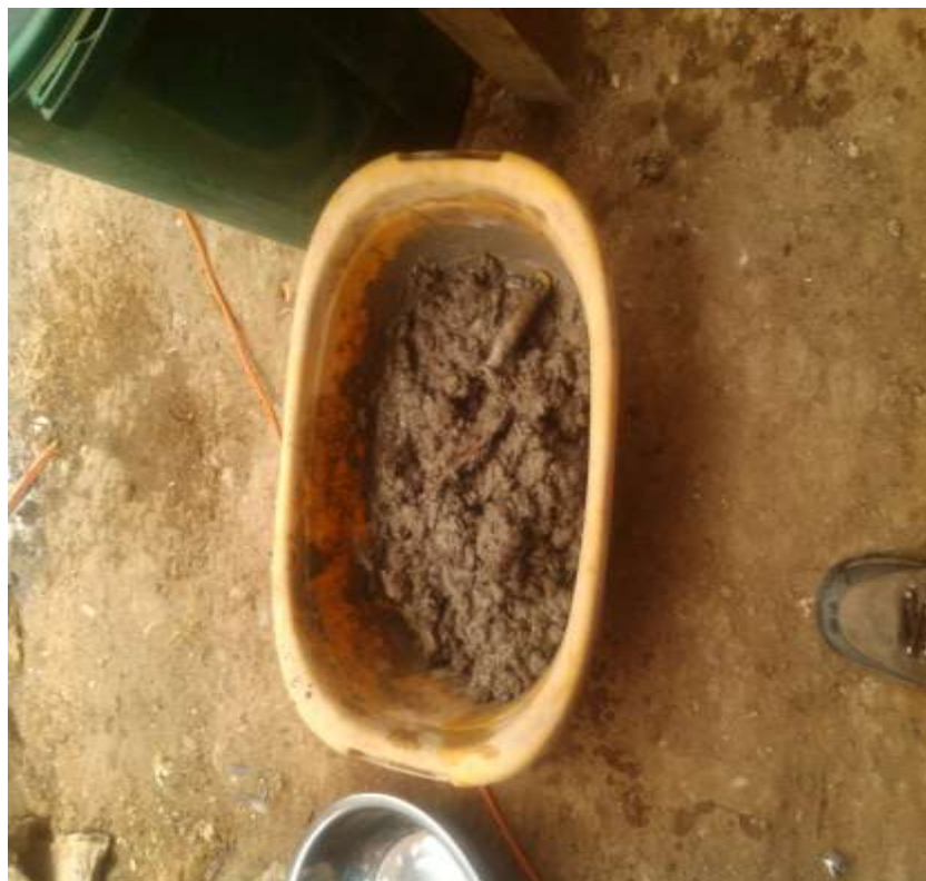
Foto 14: Mezcla de agregados e insumos para la obtención de concreto
