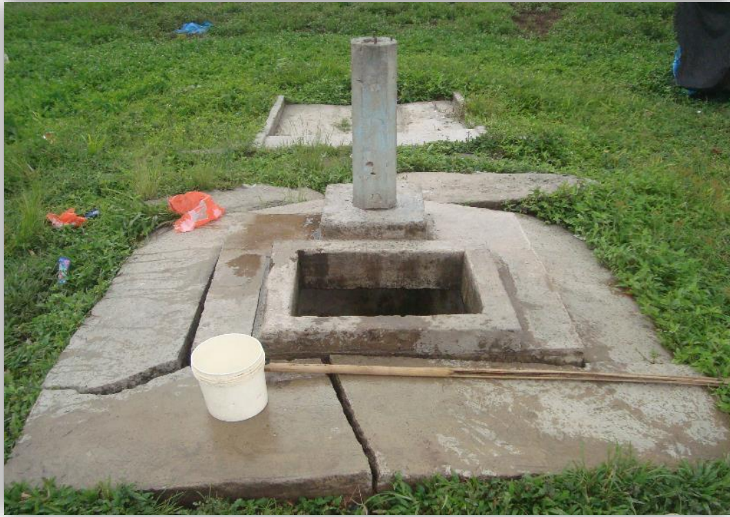
Figura 36. Pozo comunal, tipo de abastecimiento de agua.
