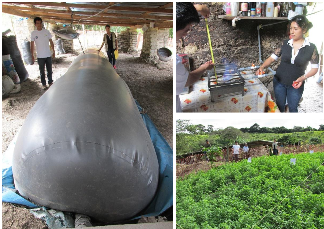
Fotografía 6. Biodigestor instalado en Naranjos, Bagua.
