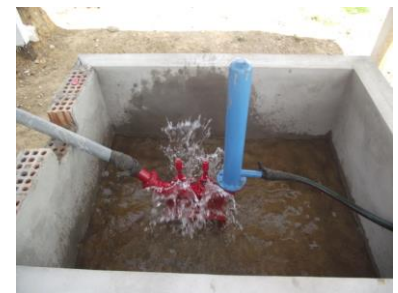
Fotografía 16. Módulos de energías renovables instalados en la UNTRM. Sede Chachapoyas.
