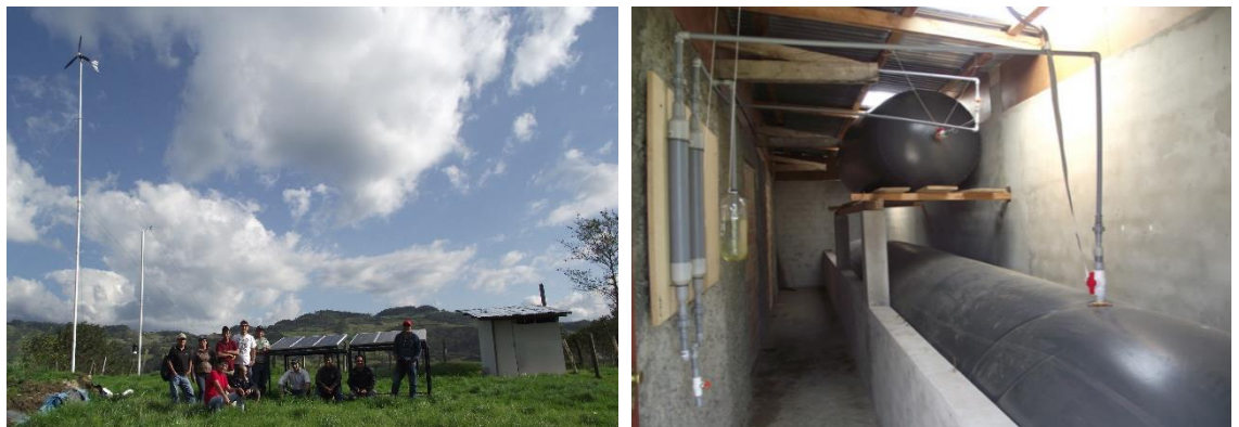
Fotografía 13. Módulos de energías renovables (sistema fotovoltaico, aerogenerador y biodigester) instalados en la Estación Experimental Pomacochas de la UNTRM.
