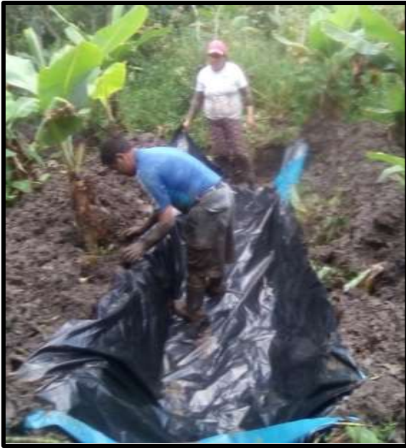
Imagen 1: Adecuación de pozas
