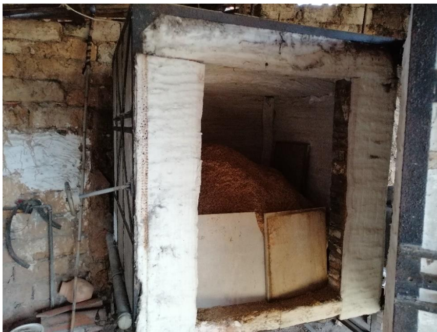
Foto N° 03. Cascarilla de arroz dentro del horno industrial para ser calcinado
