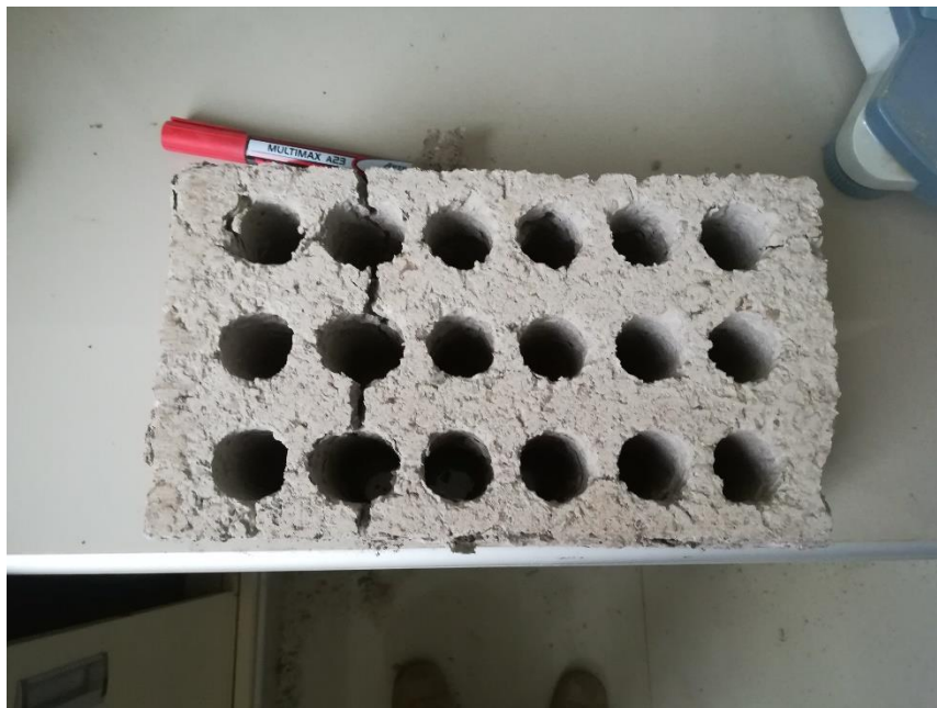
Foto N° 20. Muestra de ladrillo a los 7 días después del ensayo de resistencia a la compresión.
