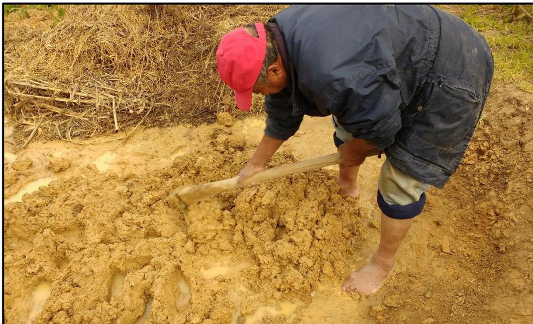
Figura 10. Picado y mezclado de barro para la elaboración de adobes.
