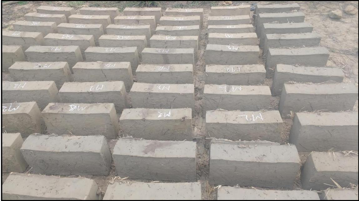
Figura 15. Colocación del adobe con adición de asfalto de canto para que complete su secado
