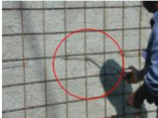
**5to paso:** Tapar las perforaciones hechas con el taladro, con una lechada de mortero, con una relación cemento: arena fina 1:3, para esta operación se usa una botella de plástico como inyector, y posteriormente se procede a tarrajear todo el muro.
