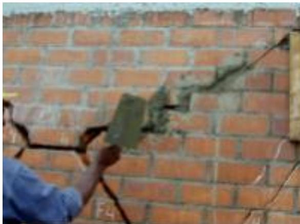
**2do paso:** El siguiente paso es pañetear al muro con un mortero cemento: arena gruesa 1:4.
