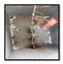
*Nota:* Las lianas o bejucos fueron introducidos antes de colocar el biodigestor en la poza, se sujetó la cuerda con los bejucos en un tubo de PVC de ½" para luego introducirlo en el biodigestor.
