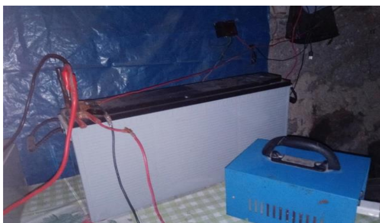
Figura 10. Conexión del panel fotovoltaico al regulador de carga del sistema.
