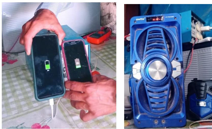
Figura 15. Carga de la batería de teléfonos celulares 70w y funcionamiento del radio grabador de 30w.
