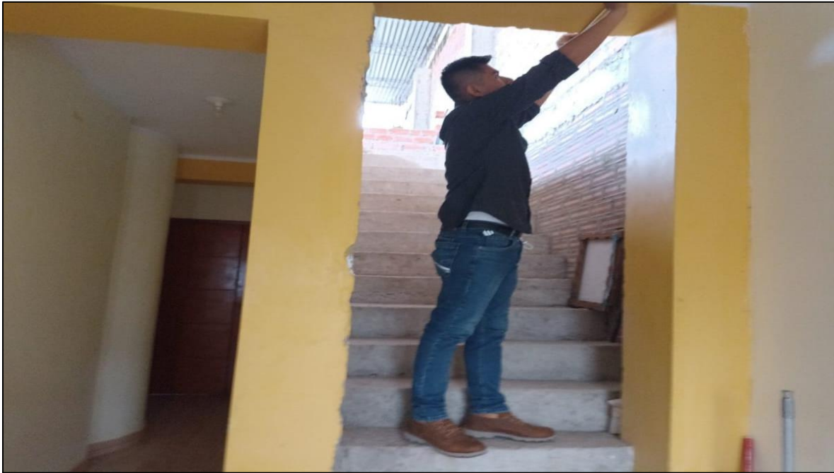
Foto 3. Muros de ladrillo pandereta en el segundo piso
