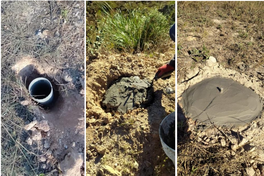
Monumentación de puntos con concreto y una varilla de fierro de 3/8"
