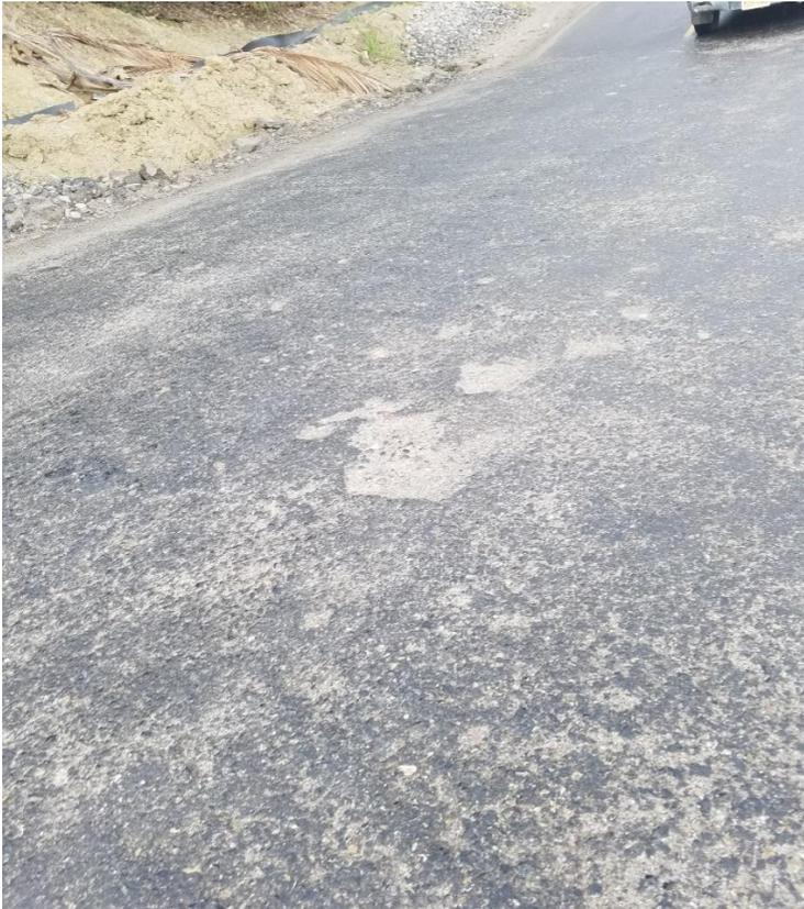
**Figura 23.** *Existencia de la falla - Desprendimientos de Agregados*
