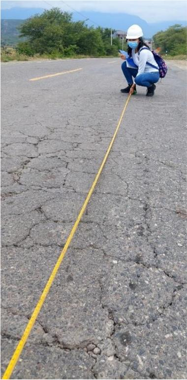
**Figura 22.** *Existencia de la falla - Hueco*
