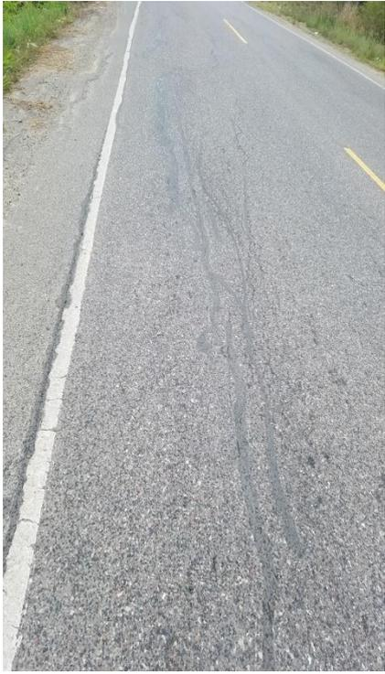
**Figura 27.** Existencia de daño - Parcheo
