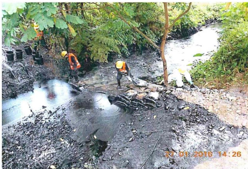
Se observa el desplazamiento del petróleo crudo derramado, el mismo que sigue el curso de la quebrada Inayo. Asimismo, se observa labores para contener el producto derramado.
