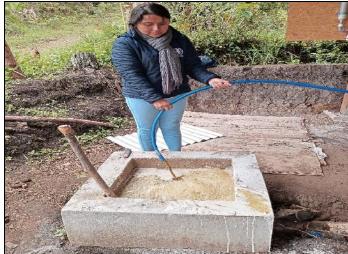
Figura 11. Mezclado de Cal con la mezcla del Biodigestor
