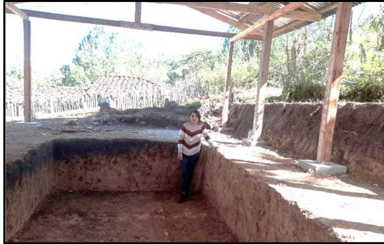
Figura 6. Excavación realizada para la zanja del biodigestor
