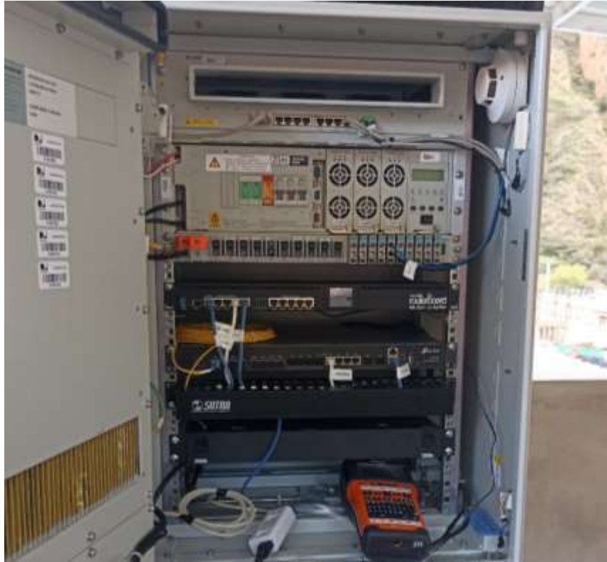
Figura 34. Instalación del Gabinete y Equipos
