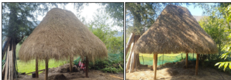
Cobertura de ichu sin perfilar
