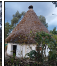
Fotografía de bungalow en la localidad de Levanto
