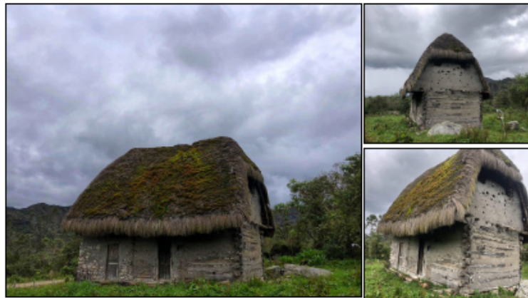
Vivienda con cobertura a cuatro aguas
