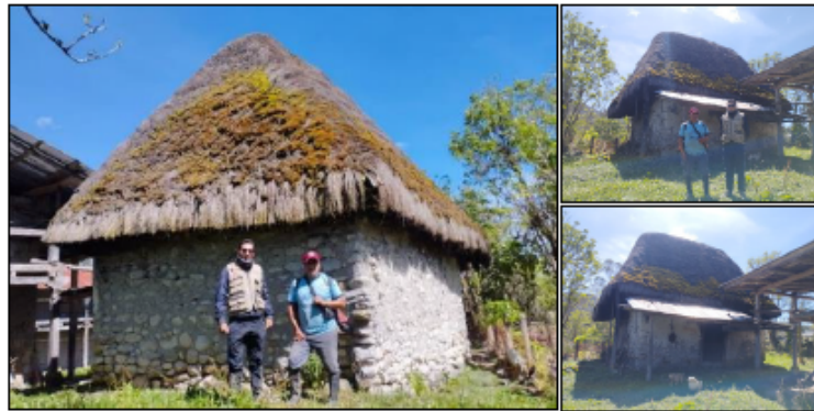
Vivienda con cobertura a cuatro aguas
