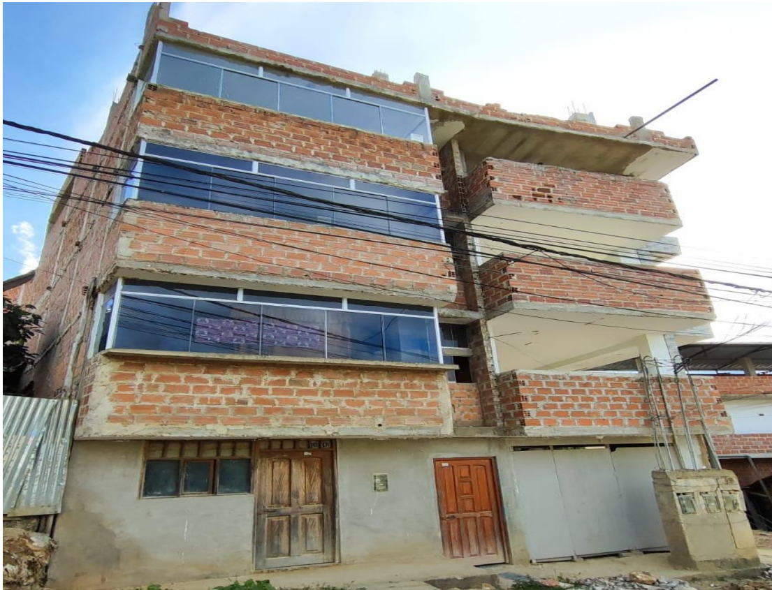
Figura 37. Vivienda de 4 niveles de albañilería en un estado regular.
