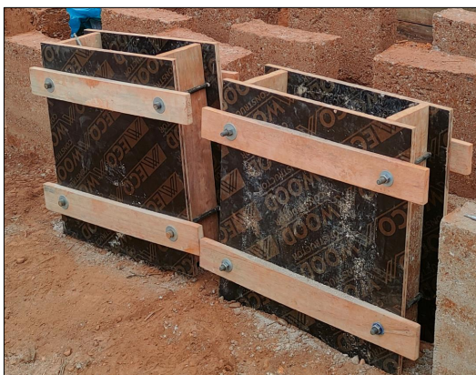
Fotografía 17.- Se observa el montaje de los moldes para la elaboración de los especímenes BTA
