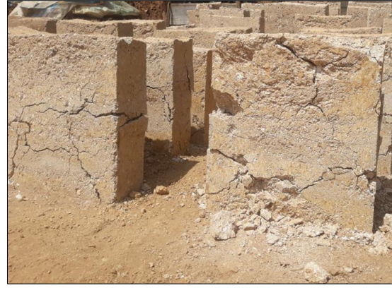
Fotografía 20.- Se observa la fisuración presentada de los especímenes del lote experimental con 15% de adición de CaO
