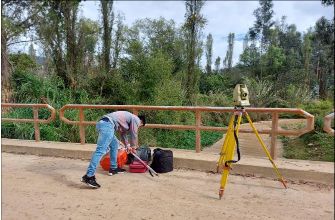
Fotografía 08: Levantamiento topográfico del puente carrozable San Martin, Lámud.
