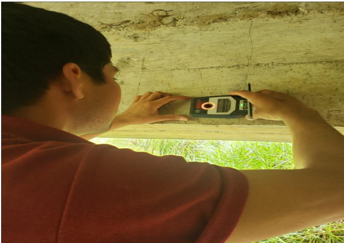
fotografía 05: Aplicación de detector de metales en viga Principal.
