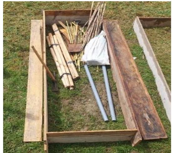
Anexo 20. Construcción de cajas
