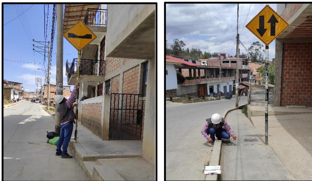
Los resaltos según el MSV definen como un dispositivo estructural fijo, que opera como reductor de velocidad en los sectores de las carreteras que atraviesan las zonas urbanas, y que consiste en la elevación transversal de la calzada en una sección determinada de la vía. Existen resaltos circulares, trapezoidales, virtuales y de cojín, los dos primeros son los más usados. Se registró el tipo, longitud de cuerda y alto de cada resalto.
