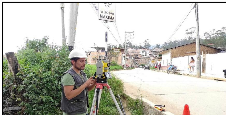
*Nota:* Puesta en estación de equipo topográfico.
