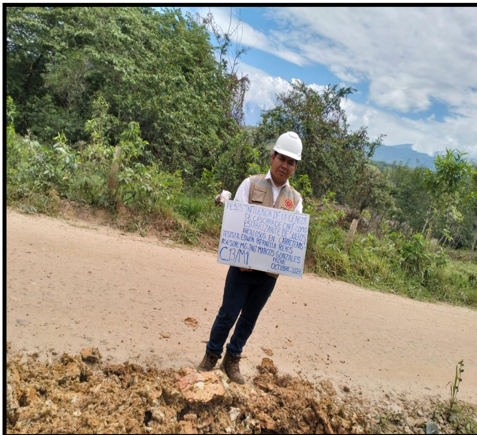
Fotográfica n° 25: Verificando los trabajos realizados en la calicata N° 13, profundidad 1.50m, en la progresiva (Km 10+000).
