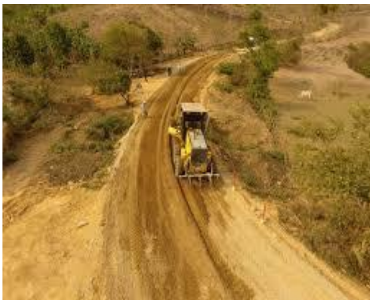
Figura 7. Mezclado con motoniveladora
