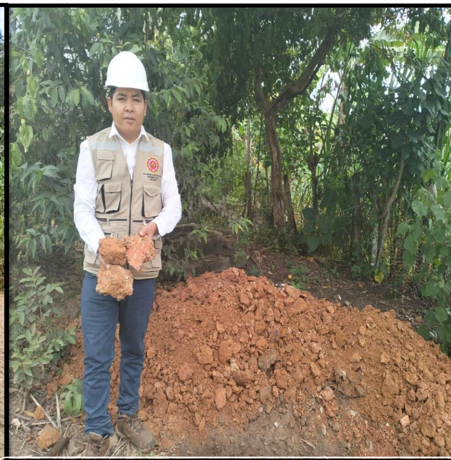
Fotográfica n° 12: Se tomaron muestras disturbadas representativas en la calicata N° 06, ubicada la progresiva (Km 6+500).
