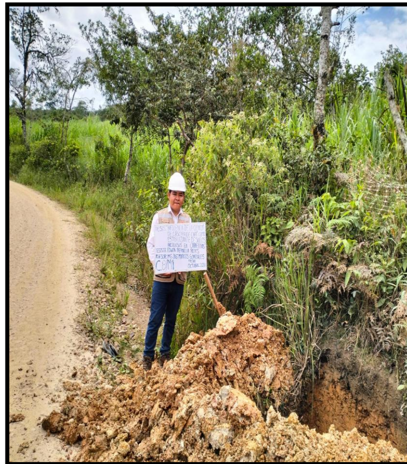
Fotográfica n° 18: Se llevó a cabo la verificación de los trabajos realizados en la calicata N° 08, en la progresiva (Km 7+500).
