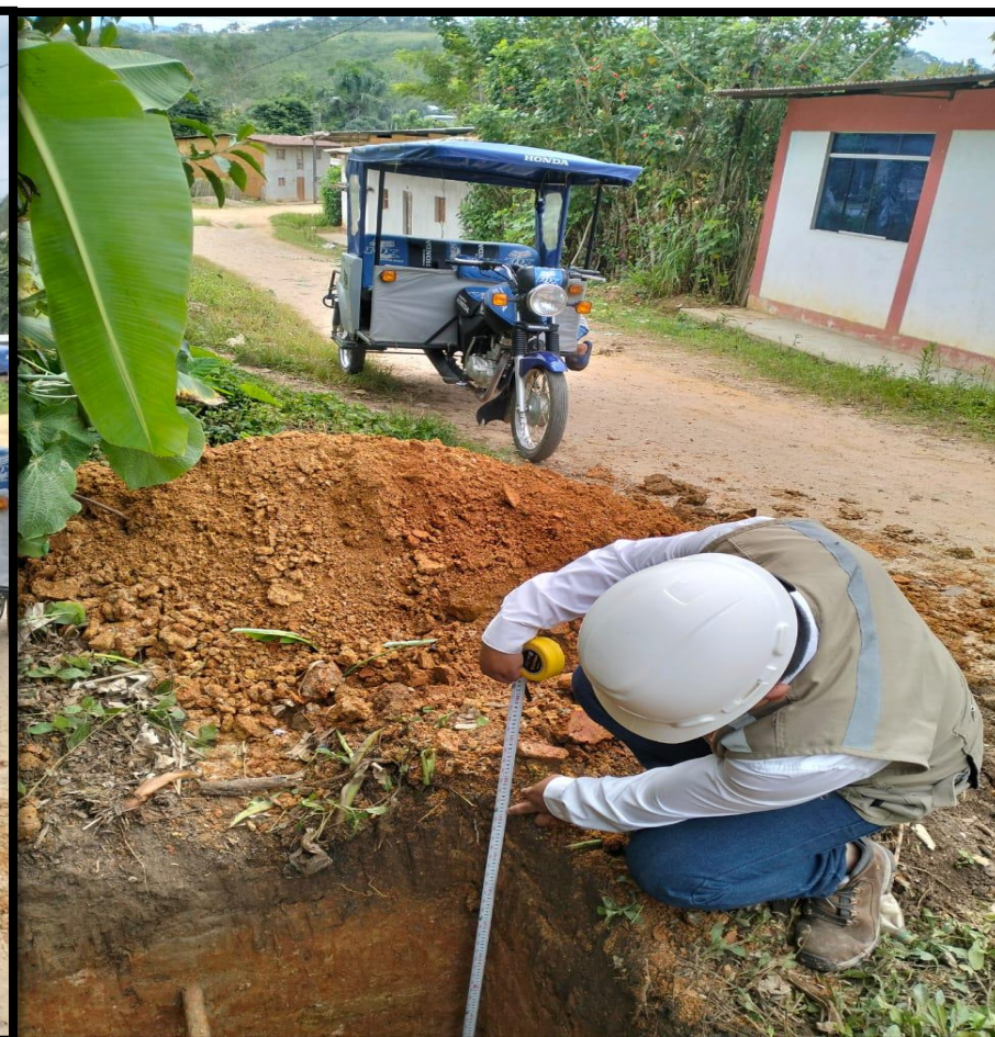
Fotográfica n° 10: Se hizo la comprobación de la excavación calicata N° 05, en la progresiva (Km 6+000).
