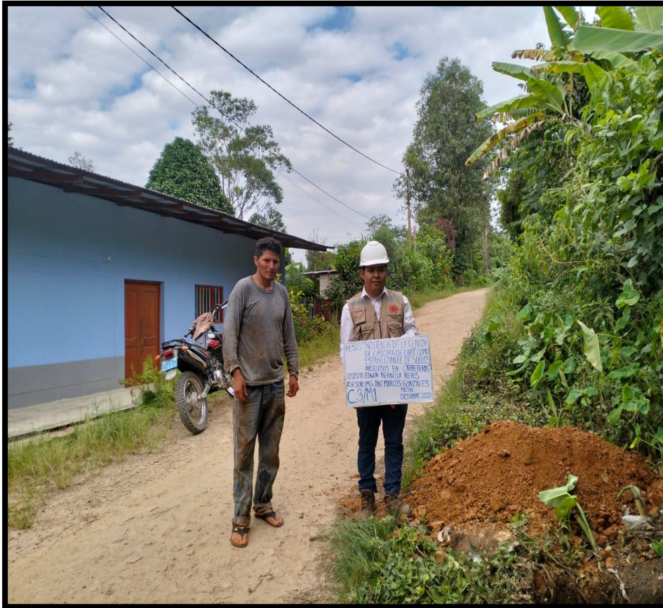
Fotográfica n° 05: Se ejecutó los trabajos de excavación en la calicata N° 03, en la progresiva (Km 5+000).
