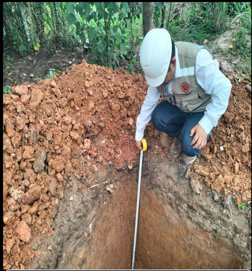
Fotográfica n° 04: Se realizó la medida de la profundidad 1.50m en calicata N° 02, ubicado en la progresiva (Km 4+500).
