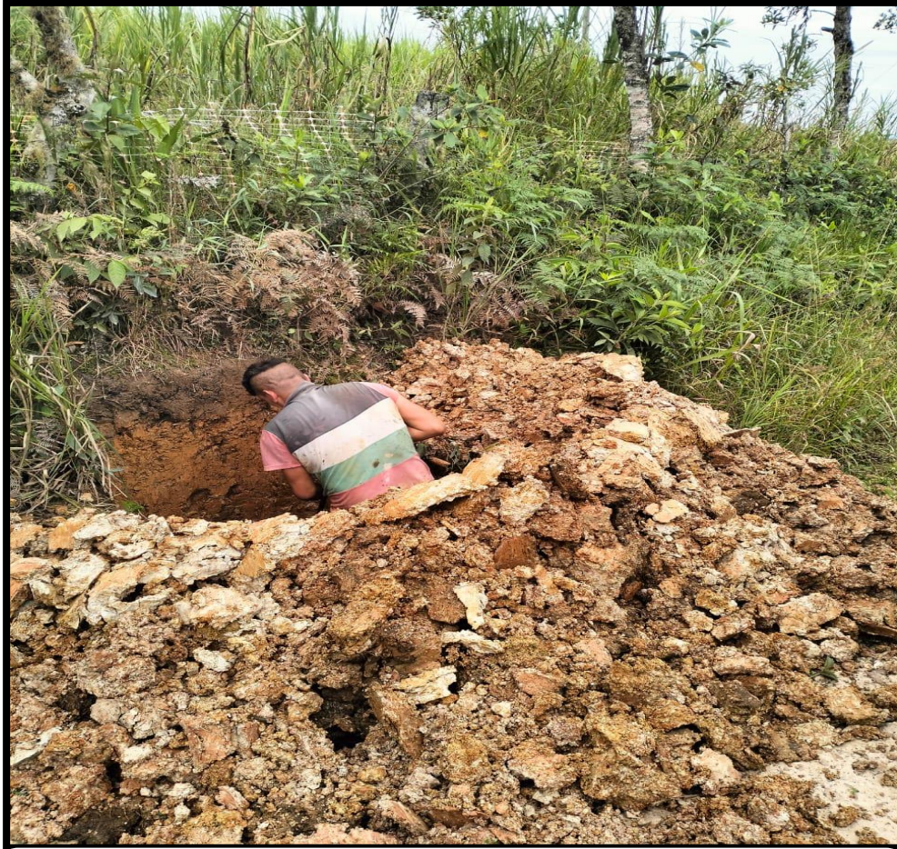
Fotográfica n° 15: Ubicación y se ejecutaron trabajos de excavación a cielo abierto en las calicatas zona de influencia del proyecto de investigación.
