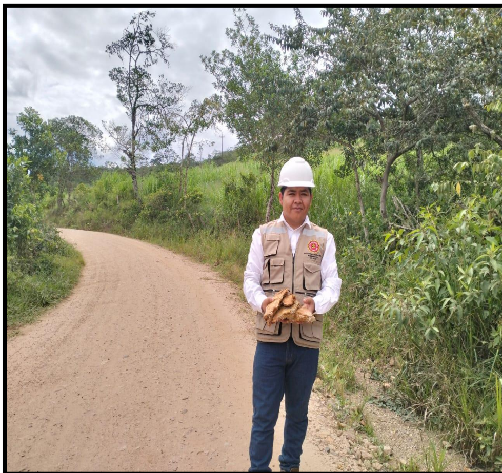
Fotográfica n° 17: Se efectuaron toma de muestra para ensayos de laboratorio de la calicata N° 08, ubicada en la progresiva Km 7+500.
