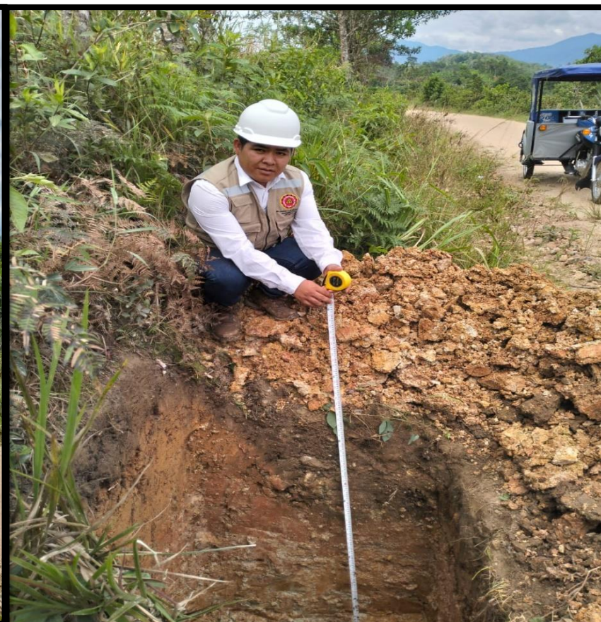
Fotográfica n° 26: Verificando los trabajos realizados en la calicata N° 13, profundidad 1.50m, en la progresiva (Km 10+000).
