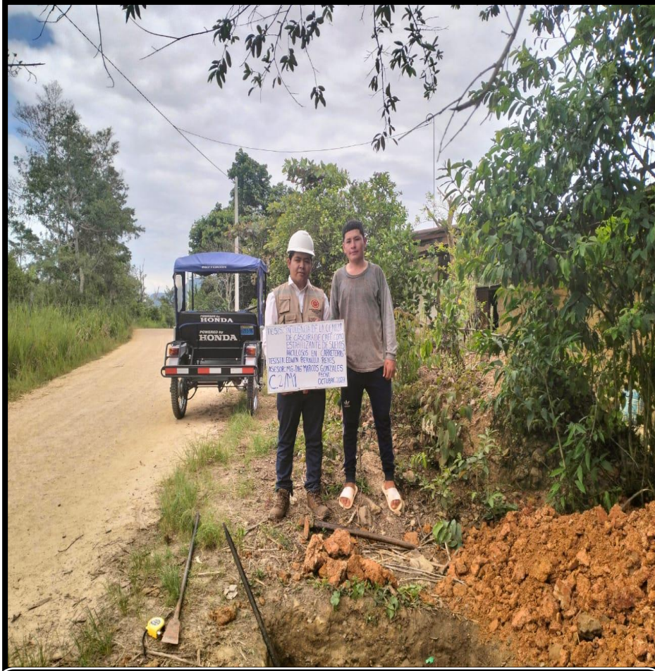
Fotográfica n° 03: Se realizó la excavación de la calicata N° 02 y la toma de muestra 1, profundidad 1.50m, en la progresiva (Km 4+500).
