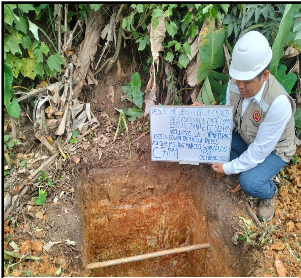
Fotográfica n° 13: Se llevaron acabo la verificación de los trabajos realizados en la calicata N° 07, en la progresiva (Km 7+000).
