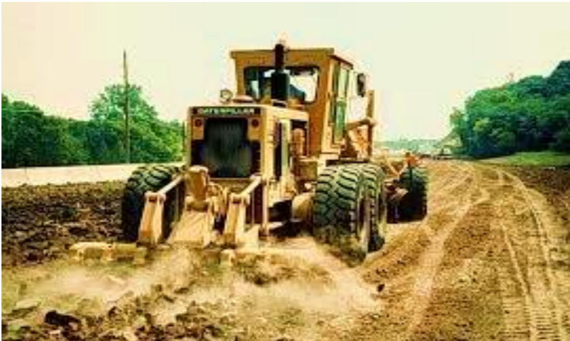
Figura 5. Escarificado de la plataforma de subrasante
