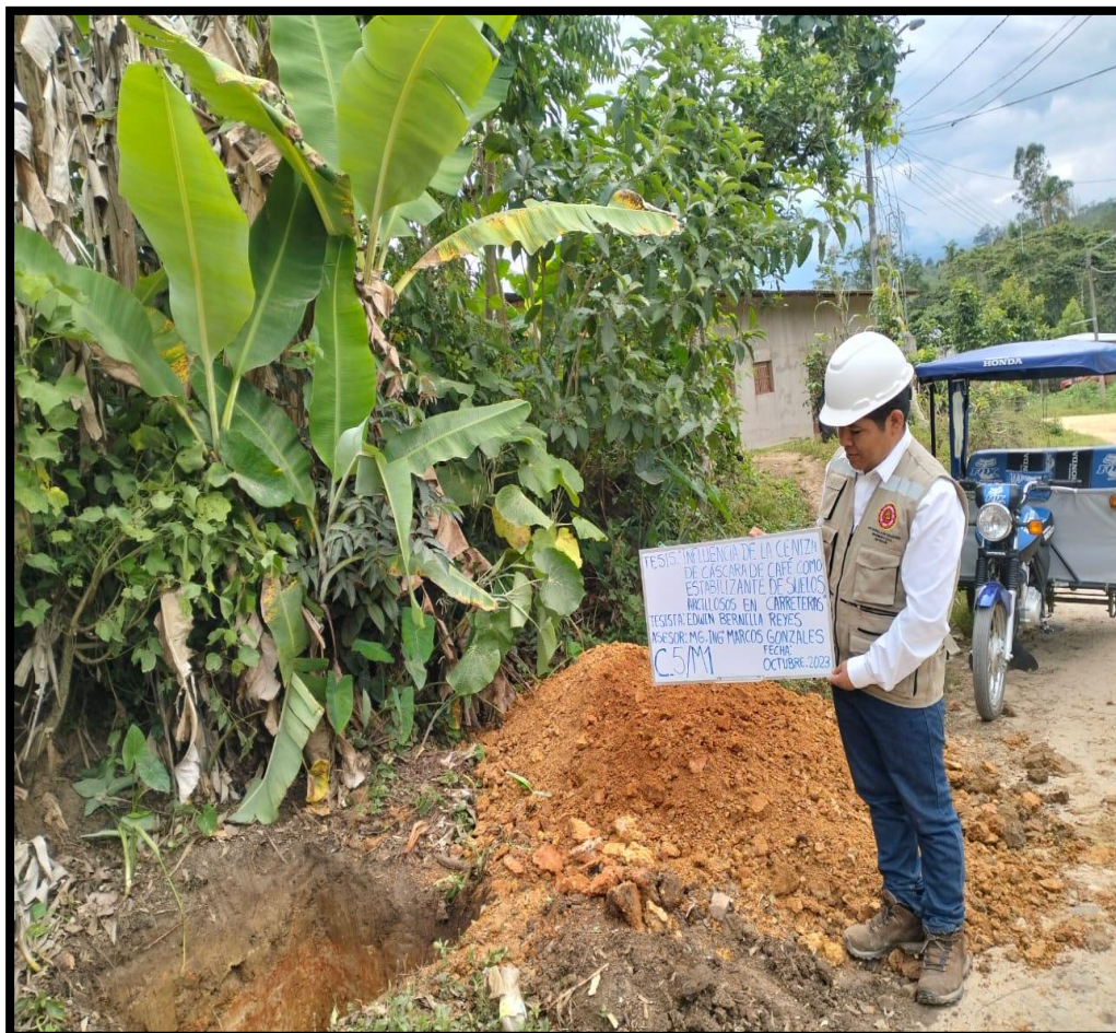
Fotográfica n° 09: Se observa los trabajos realizados en la calicata N° 05, en la progresiva (Km 6+000).
