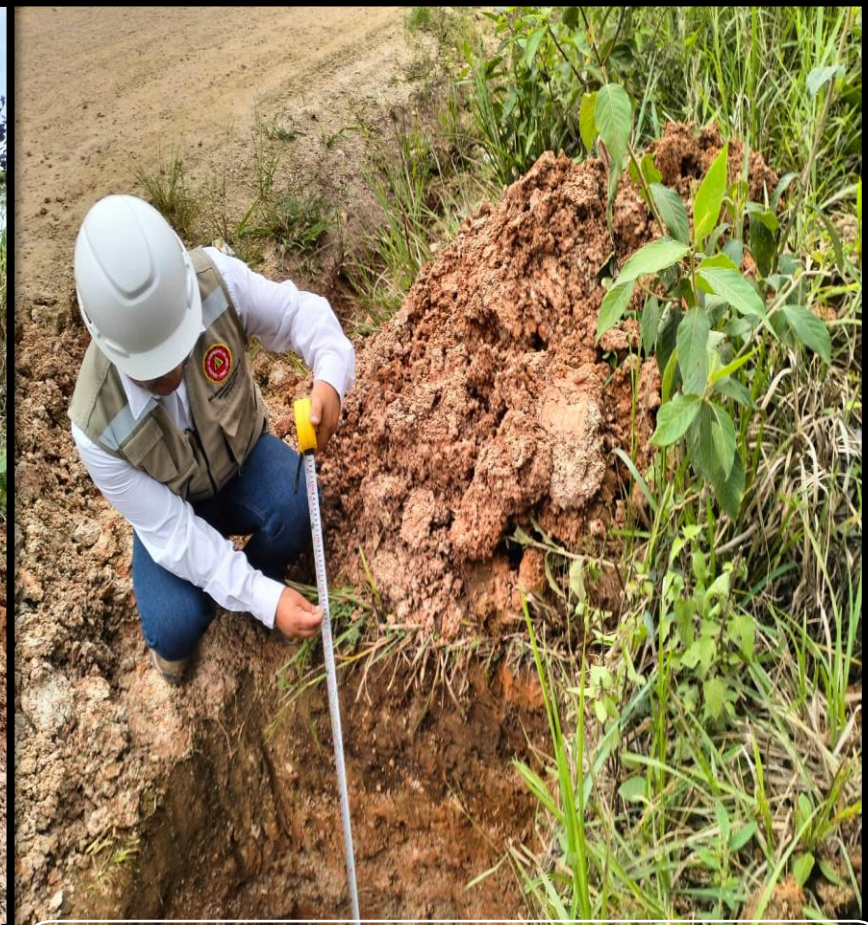
Fotográfica n° 20: Se realizó la medición de excavación de calicata N° 9 y muestra 1, profundidad 1.50m, ubicado en la progresiva (Km 8+000).
