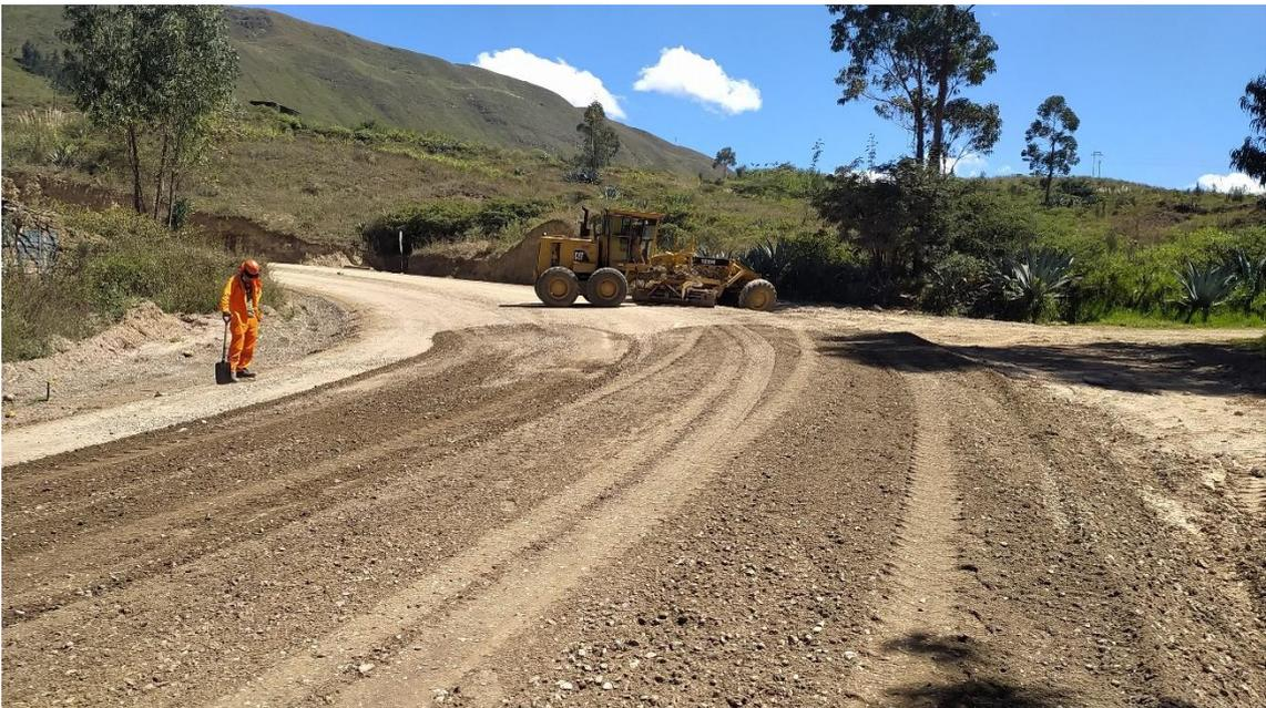
Conformación de subbase granular, se aprecia que la maquinaria hace desplazamientos innecesarios.
