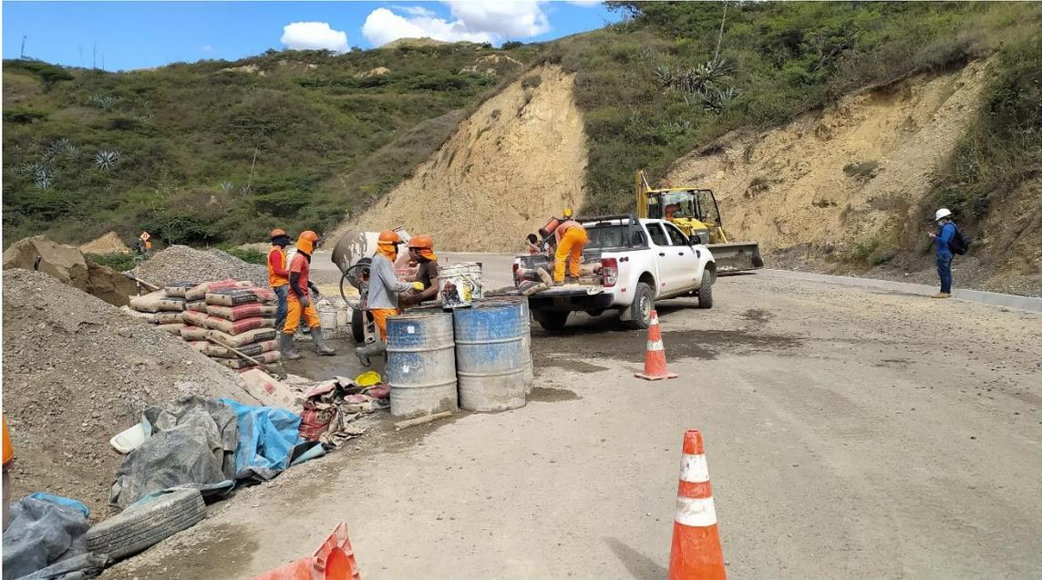
Habilitación de cemento en pleno vaciado de cunetas de concreto de tipo I, material importante que debió ser habilitado y calculado antes del inicio del vaciado.
