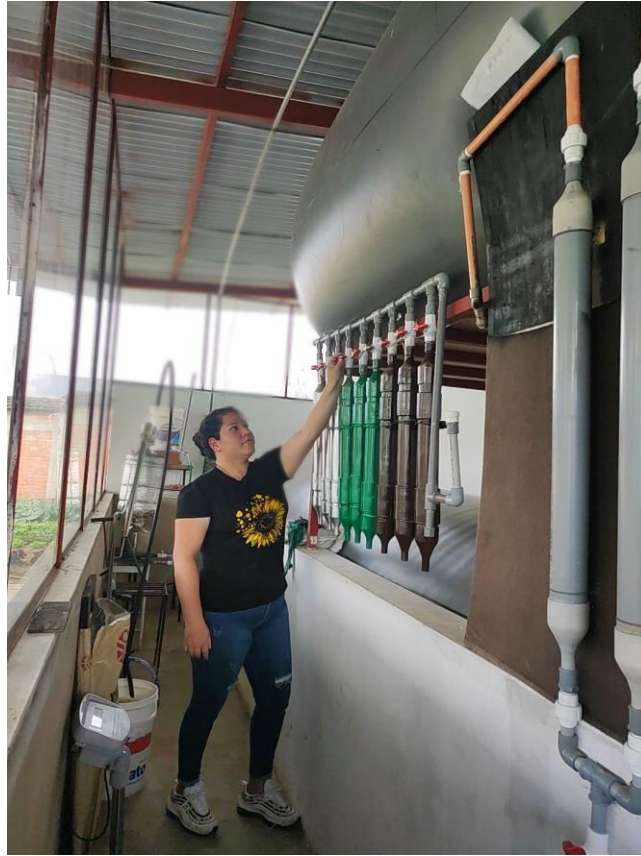
Fotografía 7. Instalación del sistema de filtros para la purificación de biogás
