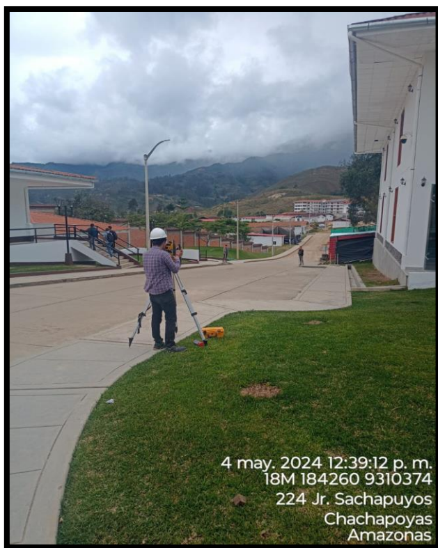
Foto 05: Levantamiento topográfico del área a intervenir
