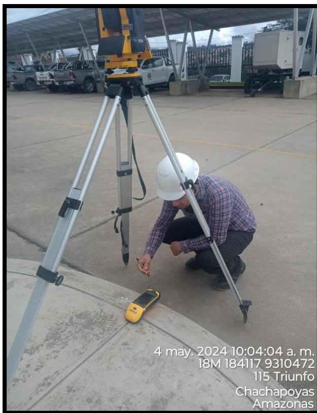
Foto 04: Medición de coordenadas de BM1, con GPS Trimble Geo7x
