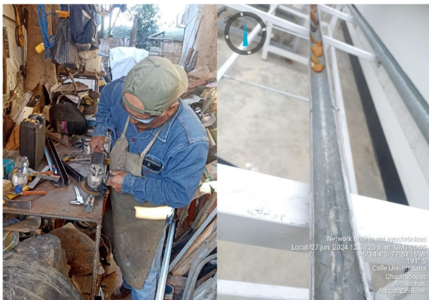
Figura 10. Adecuación de los tubos galvanizados
