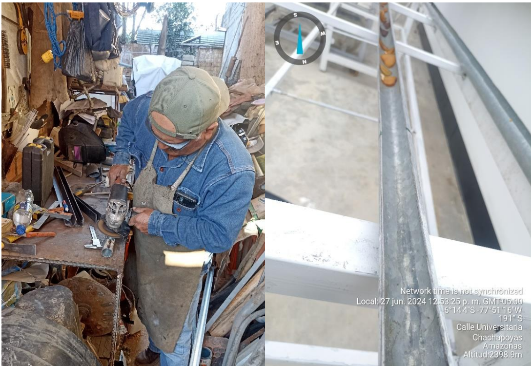
Figura 10. Adecuación de los tubos galvanizados
