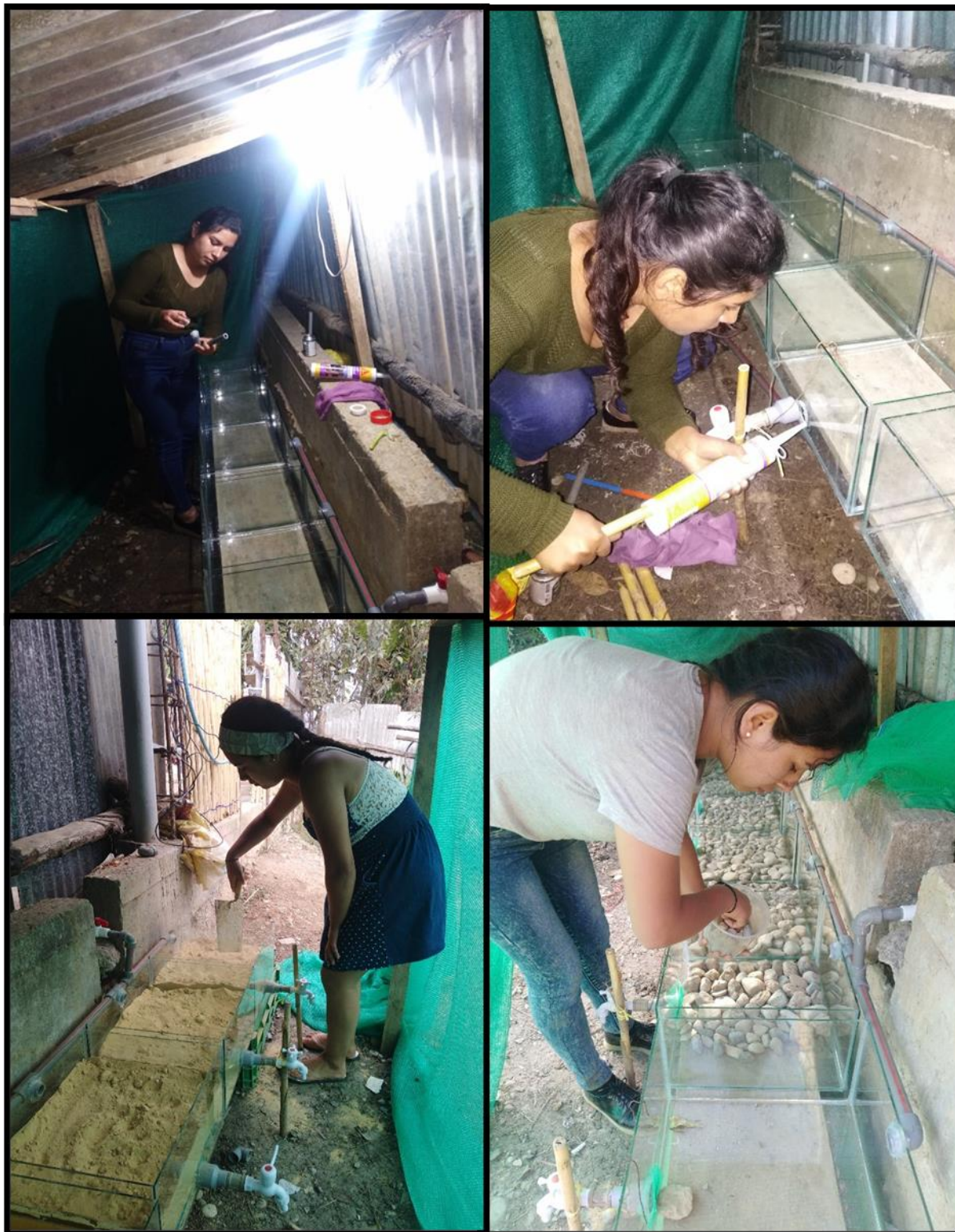
Fotografía 1: Instalación de componentes del sistema de tratamiento
