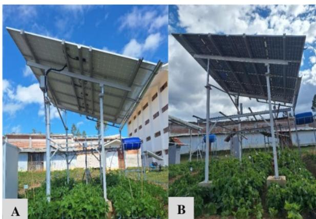
**Figura 5.** Sistema fotovoltaico monofacial. B. Bifacial.
