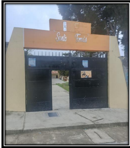
Fachada de la I.E.S. Santo Tomás
