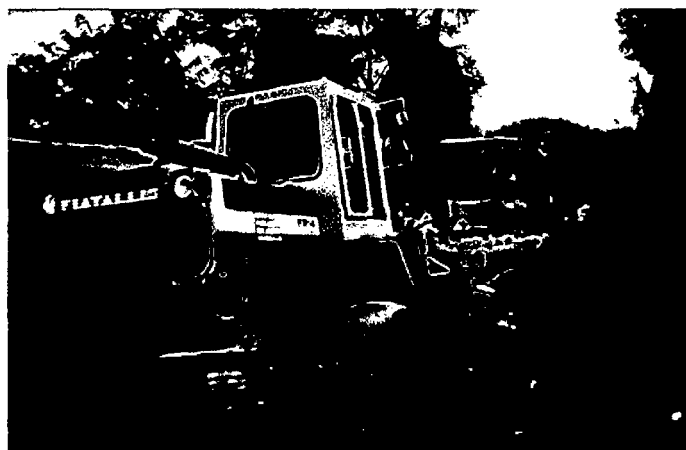
Foto n° 23. Maquinaria pesada haciendo trabajos de mantenimiento
