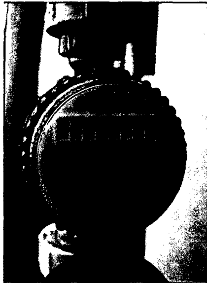
Fotografía 5. Medidor de volumen de agua.
